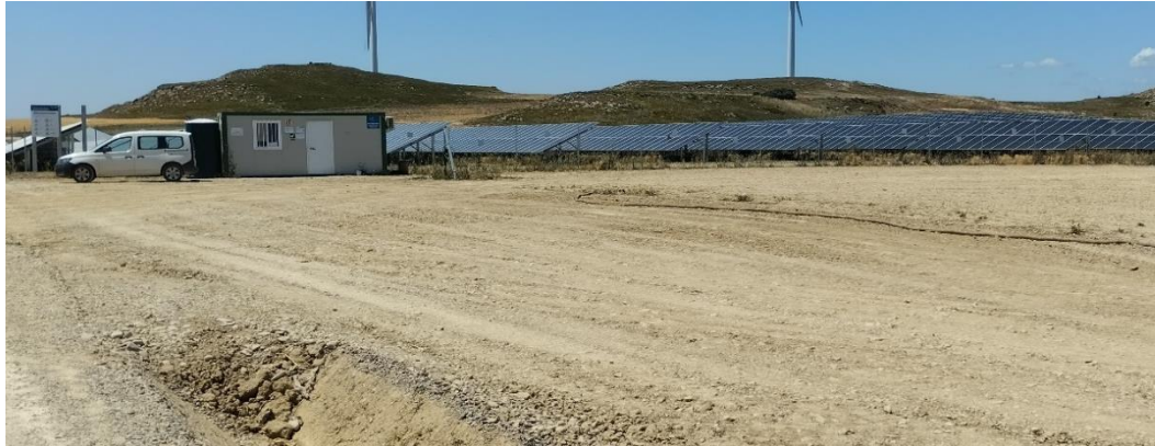
Campa de obras, el 03-06-24
