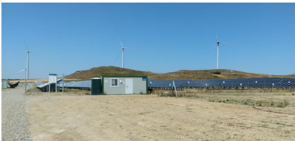
Campa de obras, el 25-06-24
