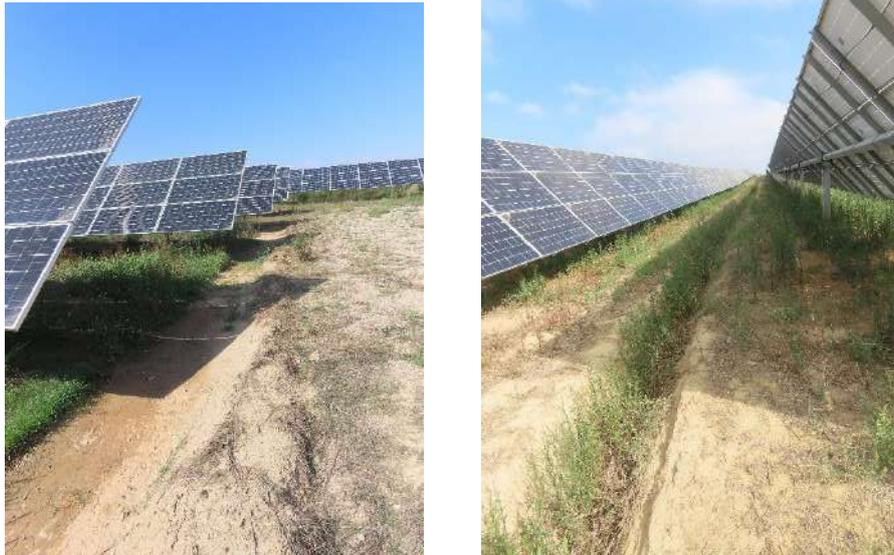
Figura 8: Cunetas en el interior del parque sin hormigonar en las que se debería retirar la vegetación.
