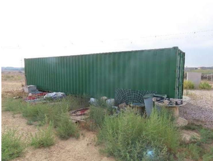
**Figura 6 : Contenedor de obra en el que se ubican los residuos y materiales de obra hasta su retirada.**
