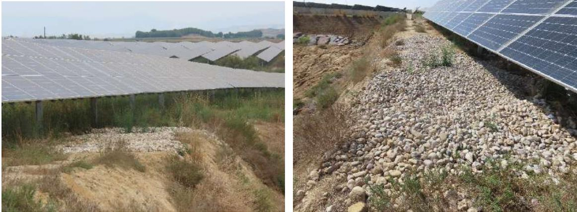
Figura 7: Cárcavas reparada con material pétreo.
