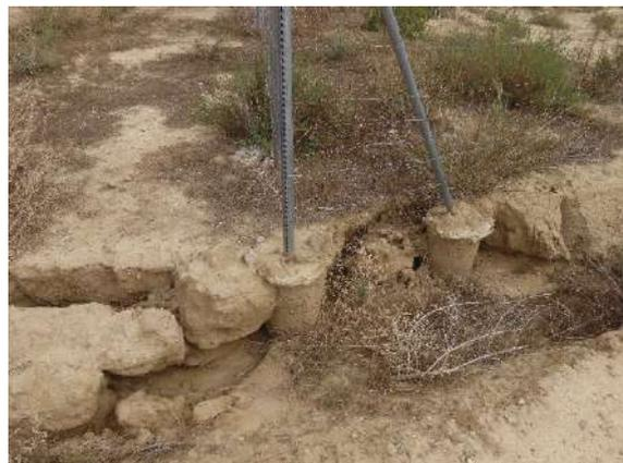
Figura 11: Problemas de erosión en la cimentación de algunos postes del vallado perimetral (visita del 13/10/2023)
