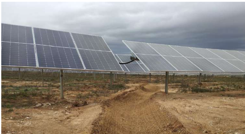
Fotografía 12. Malla de coco colocada entre trackers
