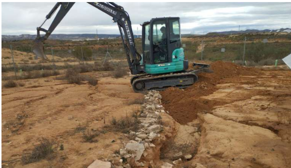
Fotografía 11. Colocación escolleras y relleno terreno
