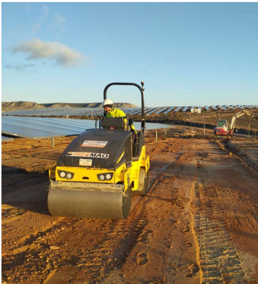
Fotografía 9. Detalle compactado cárcavas y escorrentía
