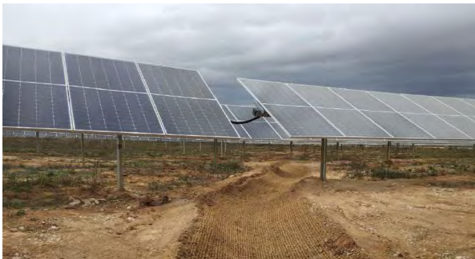
Fotografía 12. Malla de coco colocada entre trackers
