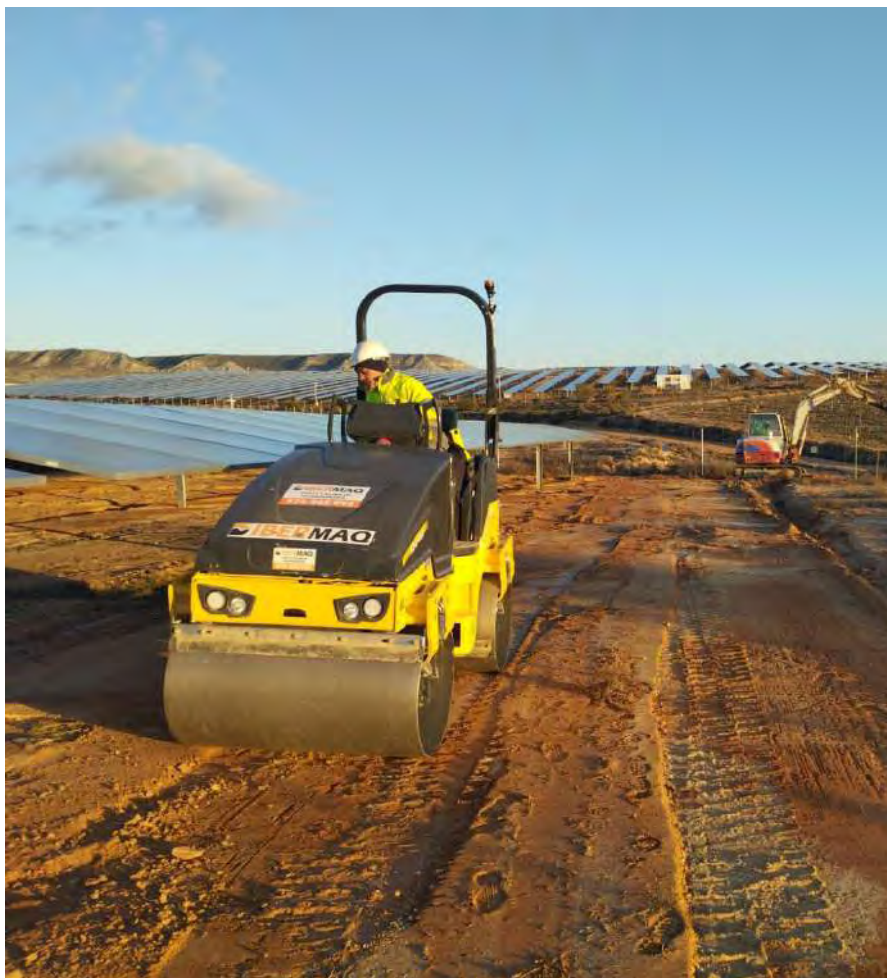
Fotografía 9. Detalle compactado cárcavas y escorrentía
