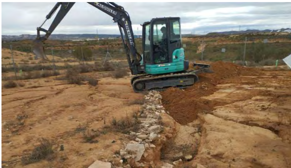
Fotografía 11. Colocación escolleras y relleno terreno
