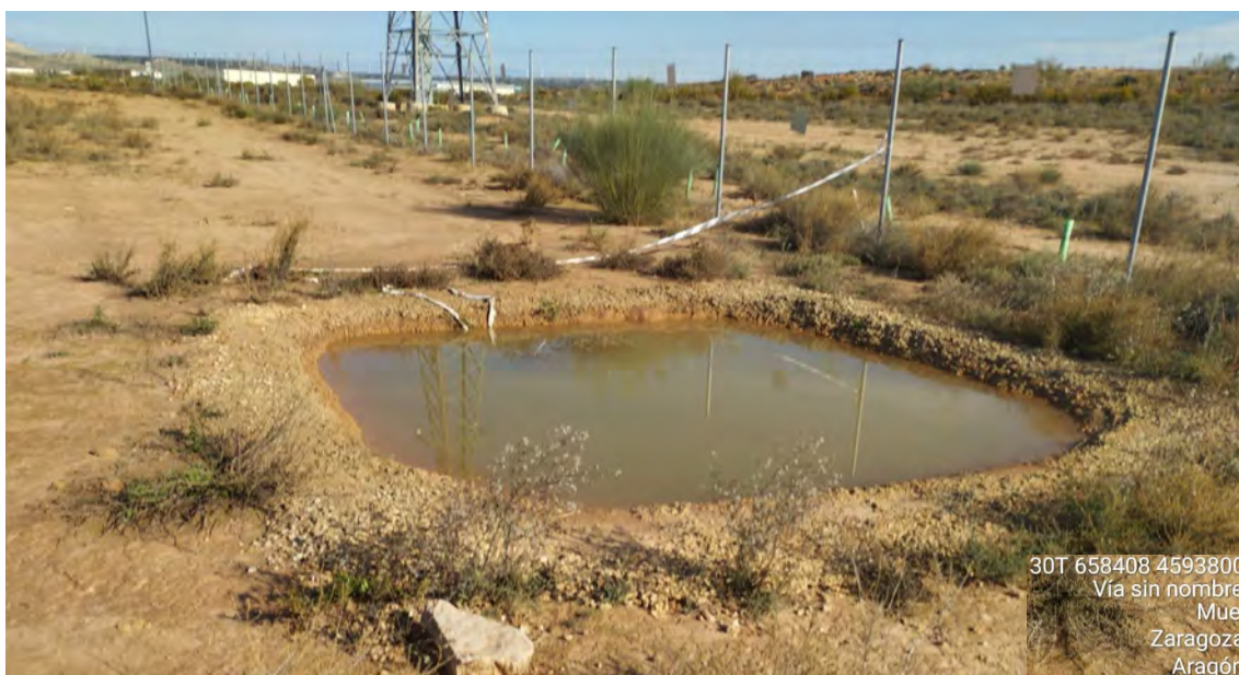
Fotografía 10. Estado actual de la balsa bebedero
