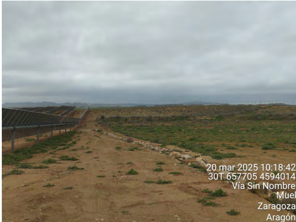
Fotografía 7. Soluciones de escollera para frenar escorrentías
