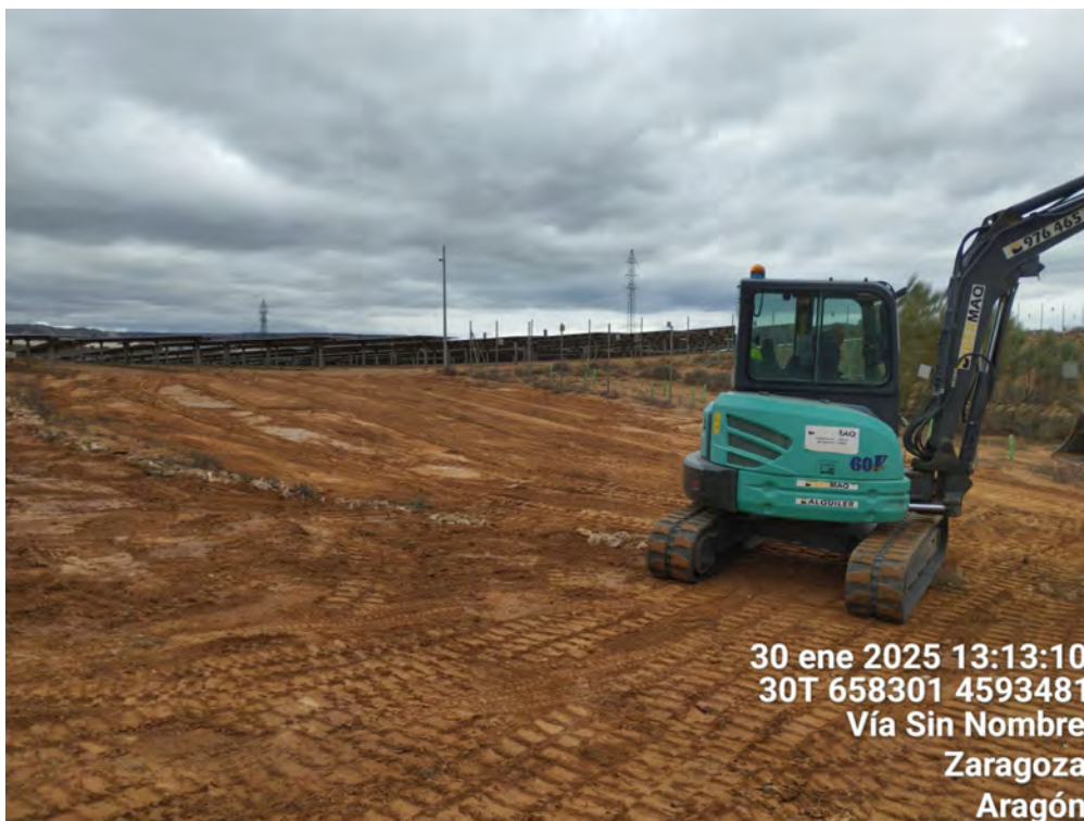
Fotografía 6. Corrección cárcavas y signos de erosión
