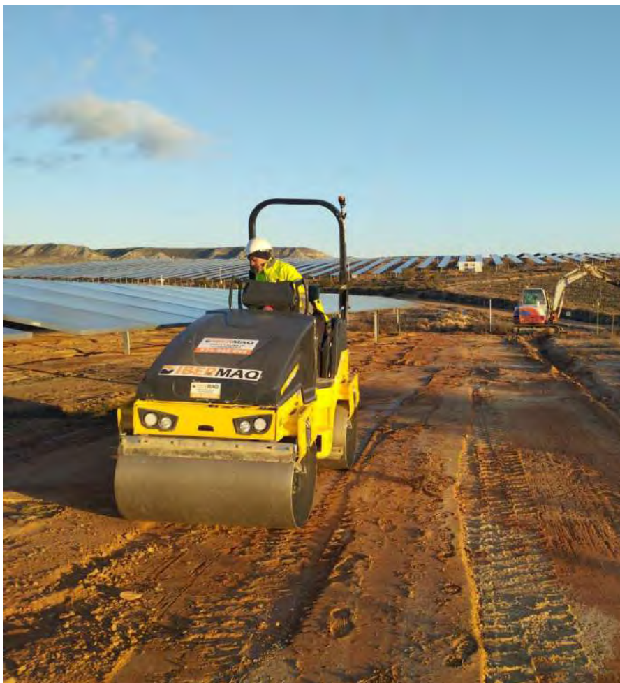
Fotografía 9. Detalle compactado cárcavas y escorrentía
