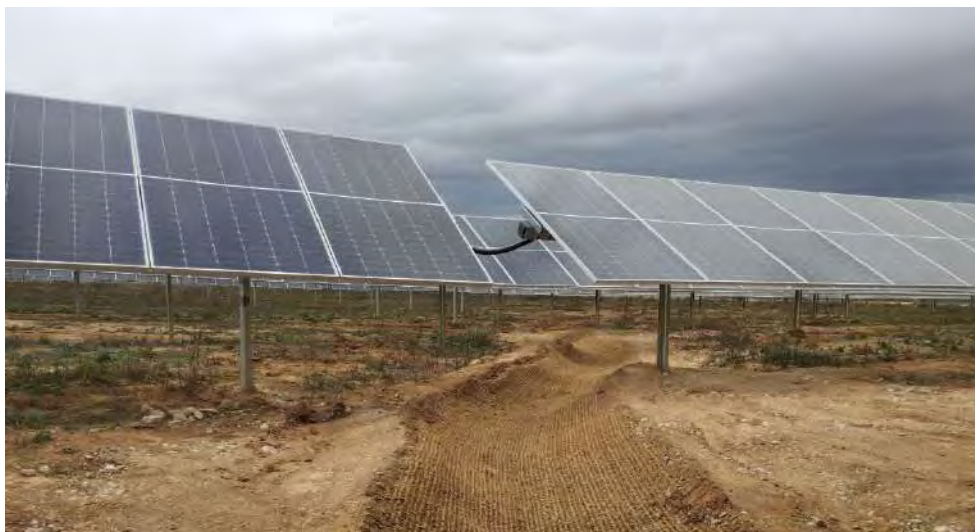
Fotografía 12. Malla de coco colocada entre trackers
