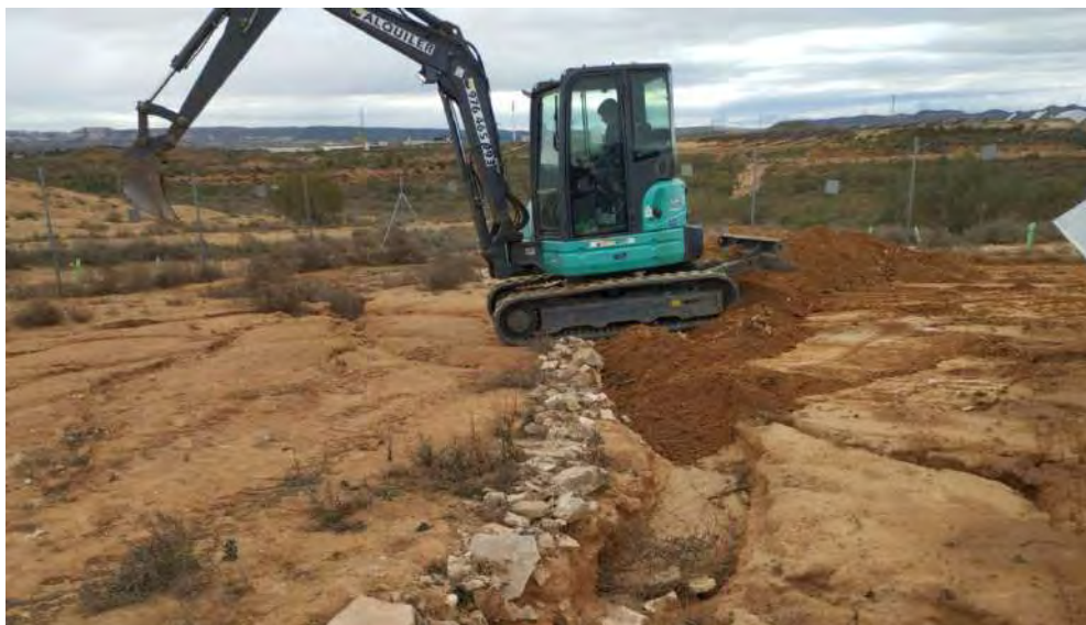
Fotografía 11. Colocación escolleras y relleno terreno
