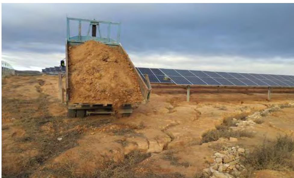
Fotografía 10. Relleno cárcavas y signos de erosión
