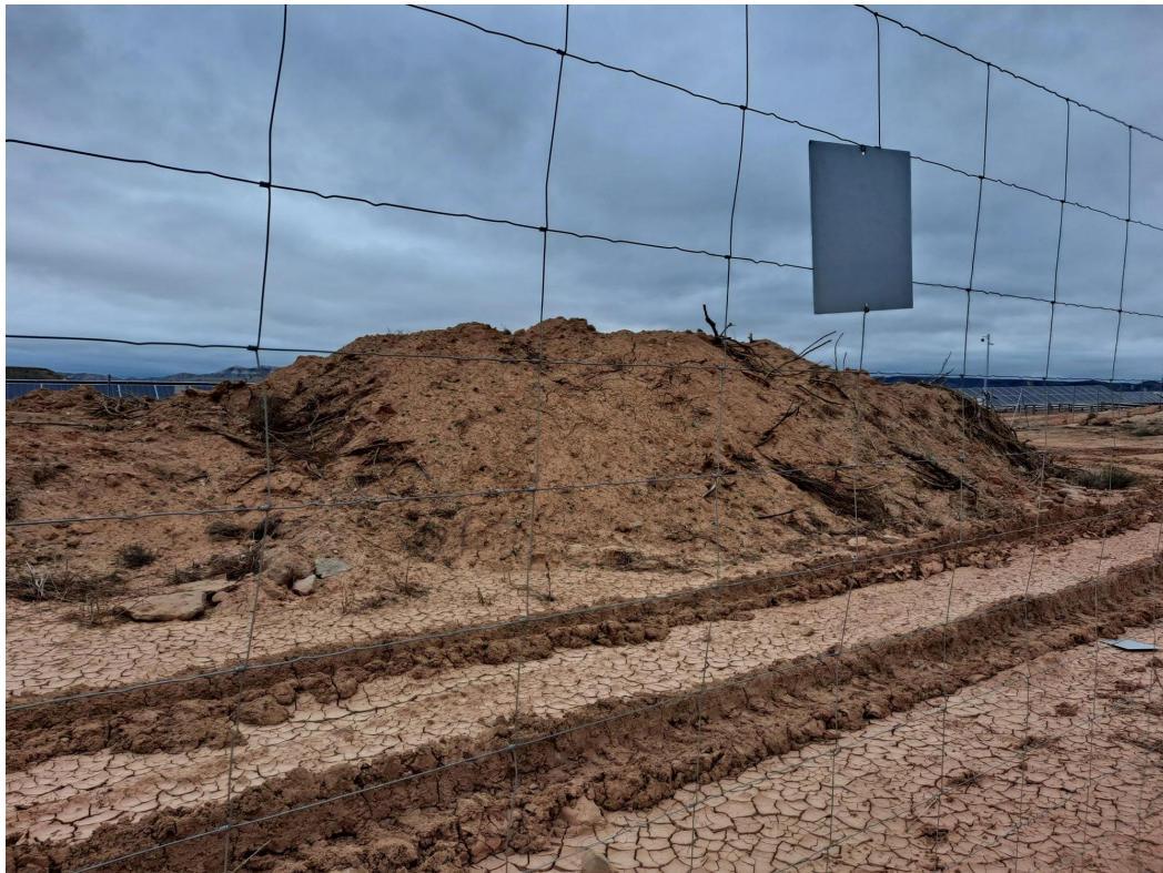
Fotografía 5. Reutilización de la tierra acopiada in situ
