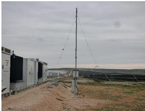
Imagen 6. Periódicamente el promotor revisa las cintas de plástico instaladas en los sensores de las torres anemométricas cuya finalidad es incrementar la visibilidad de los mismos por parte de la avifauna
