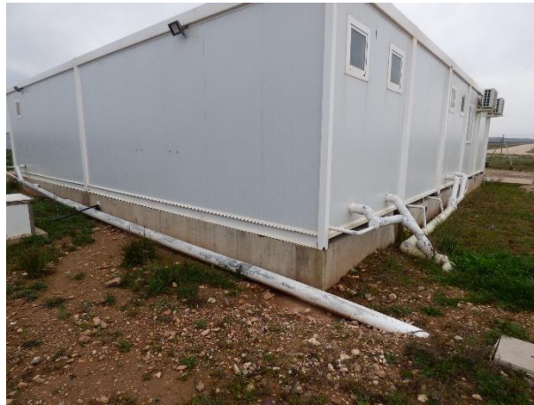
Imagen 4. Tuberías de salida de las aguas residuales de los aseos del edificio de O&M, sin evidencias de desbordamientos
