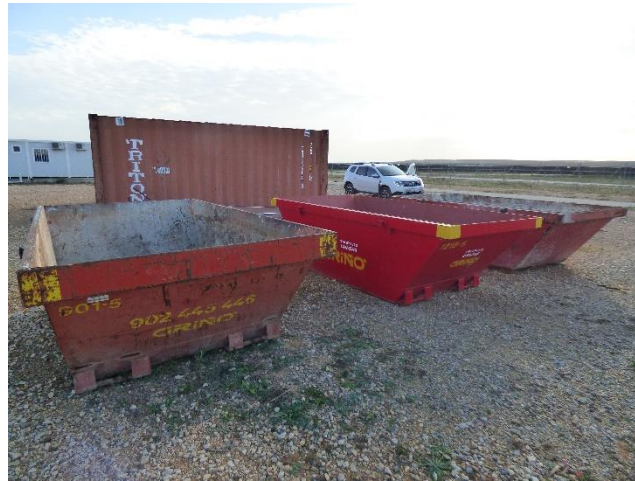
Imagen 17. Contenedores de obra habilitados para el depósito de residuos no peligrosos
