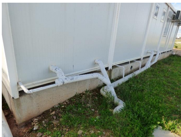
Imagen 2. Tuberías de salida de las aguas residuales de los aseos del edificio de O&M, sin evidencias de desbordamientos
