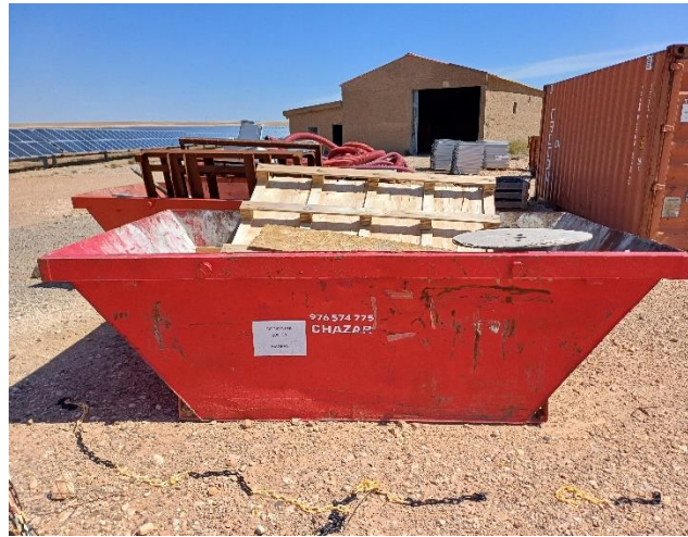
Imagen 19. Contenedor habilitado para el depósito de madera adecuadamente identificado
