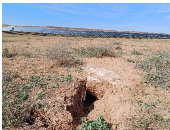
Imagen 14. Madriguera en el interior de una de las plantas fotovoltaicas
