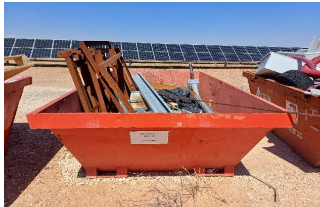
Imagen 20. Contenedor habilitado para el depósito de chatarra adecuadamente identificado
