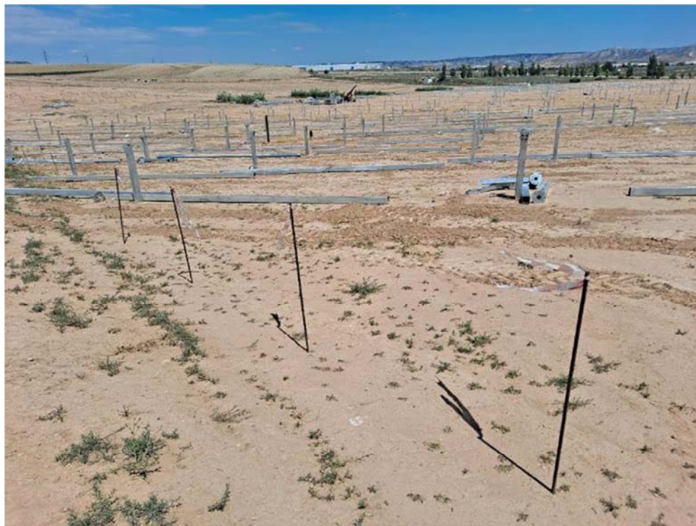
Figura 8.7. Aspecto de la planta el 14-06-2024. Se siguen realizando hincas y se están repartiendo los seguidores
