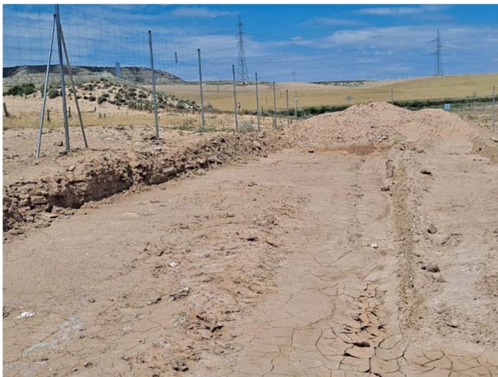
Figura 8.11. Pequeños movimientos de tierra realizados en la esquina norte de la parcela. Acopio de tierras.
