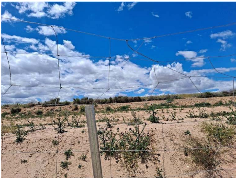
Figura 8.7. Poste doblado en el límite suroccidental de la parcela. El vallado se ha roto, dejando elementos punzantes peligrosos para la fauna
