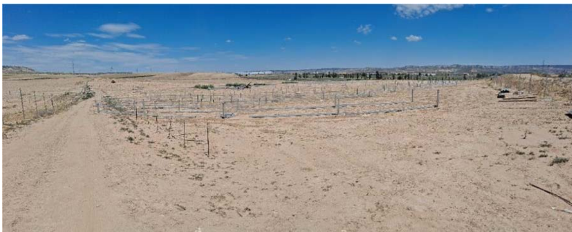
Figura 4.1. Aspecto de la parcela a fecha 14-06-2024, con parte de los postes verticales hincados y seguidores repartidos
