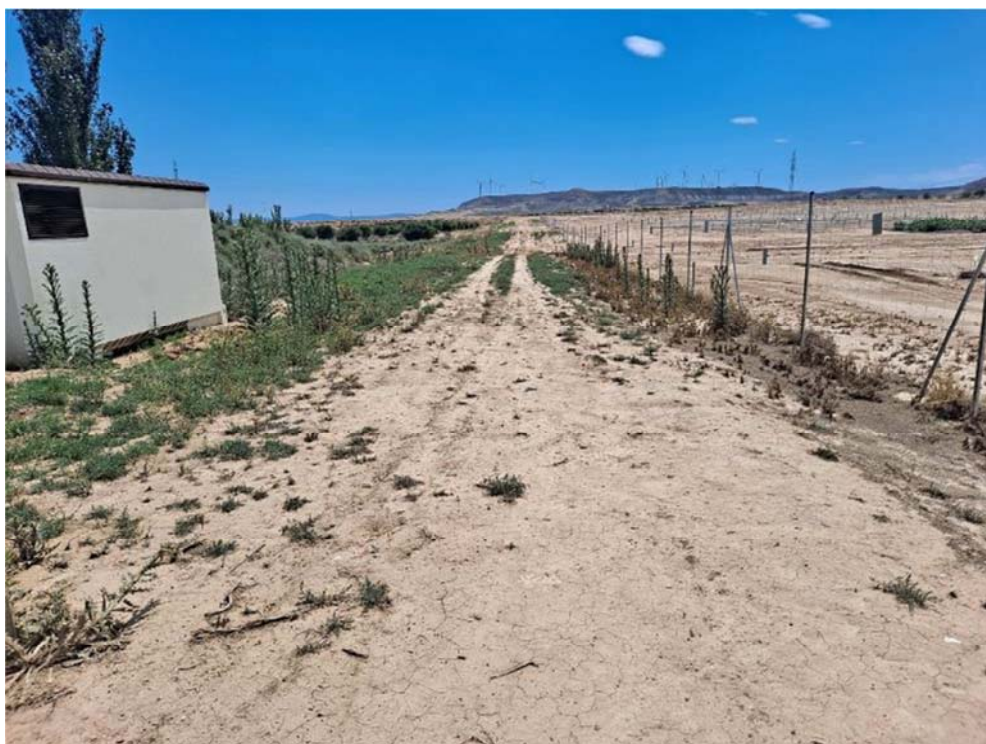
Figura 8.14. Tierra vegetal acopiada en el límite suroriental. Se encuentra compactado y con marcas de rodadas
