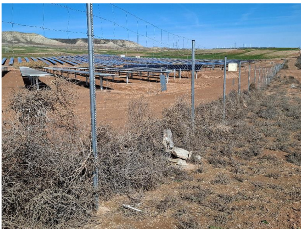
Figura 8.8. Acumulación de vegetación en el extremo suroriental de la planta, a fecha 13-02-2025.
