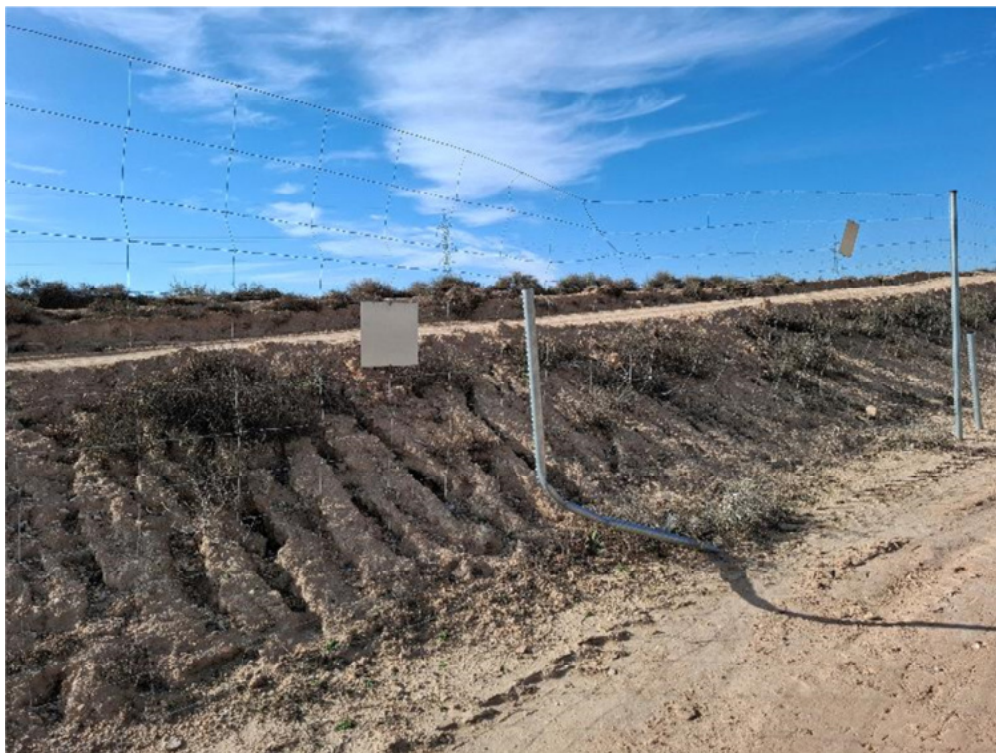
Figura 8.3. Poste doblado y vallado roto, con elementos punzantes peligrosos para la fauna, en el límite suroeste.
