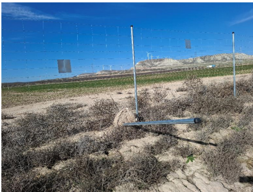
Figura 8.6. Poste descalzado como consecuencia del reguero que discurre por el sector noroccidental de la planta.
