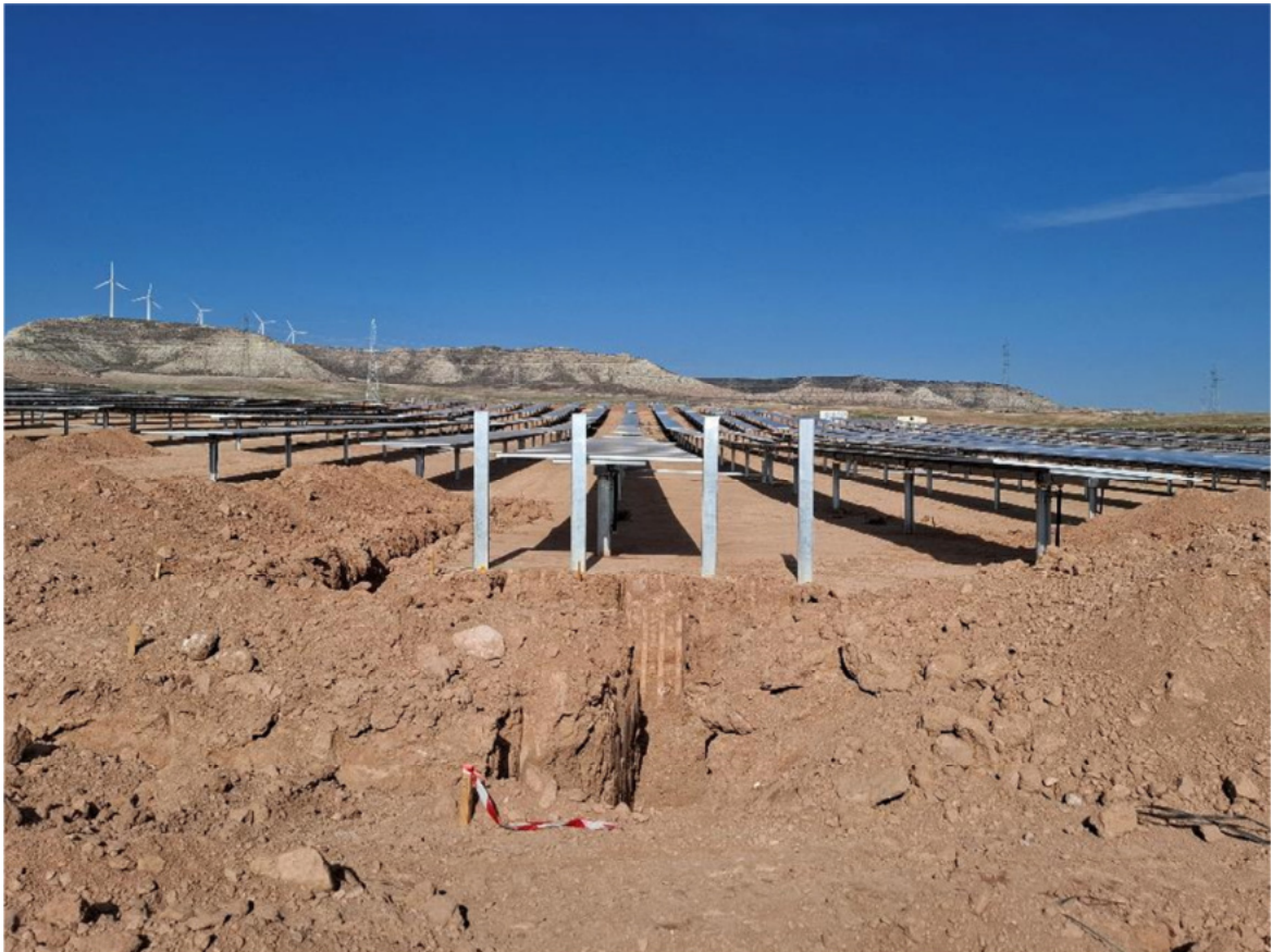
Figura 4.1. Postes para la colocación de inversores
