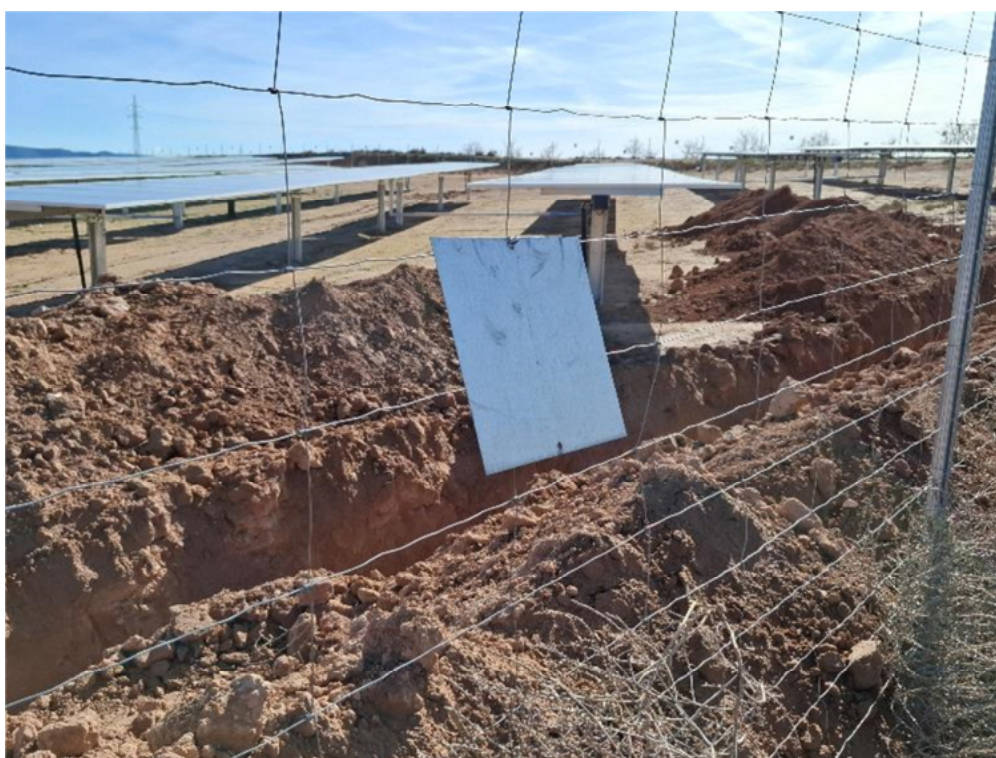
Figura 8.7. Placa con un solo punto de anclaje, con riesgo de caída.
