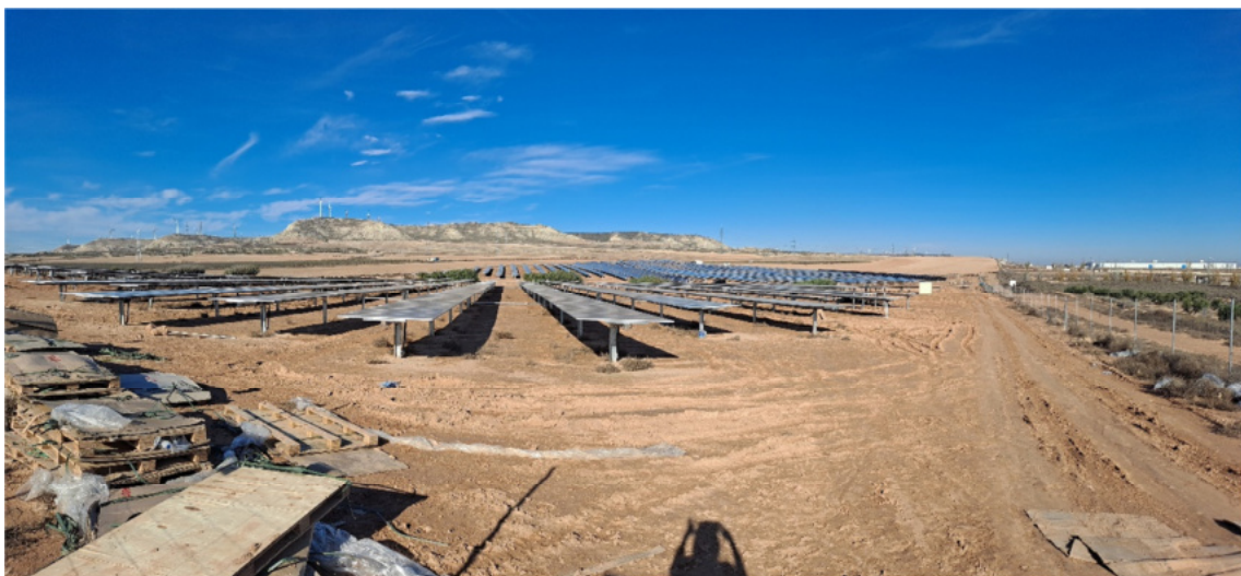
Figura 8.1. Aspecto de la planta el 27-11-2024. Se están colocando placas solares y se han instalado los centros de transformación
