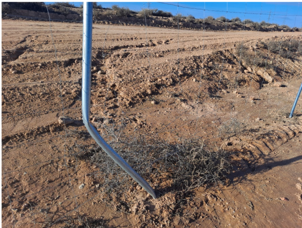
Figura 8.19. Poste doblado y vallado roto en el extremo suroccidental de la parcela, generando elementos punzantes peligrosos para la fauna
