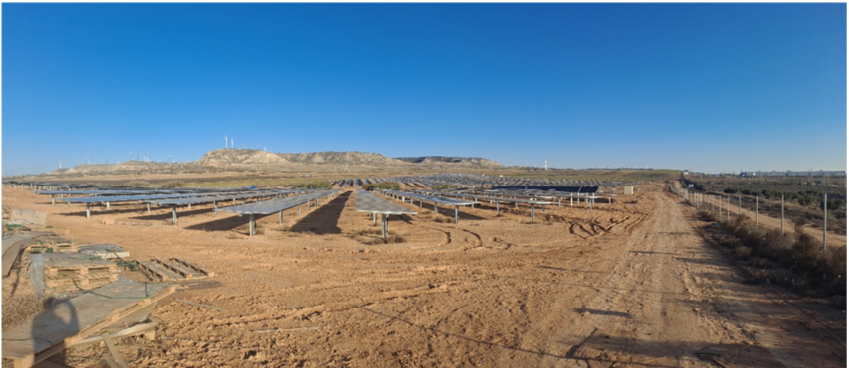
Figura 4.1. Aspecto de la parcela a fecha 18-12-2024, con las placas colocadas
