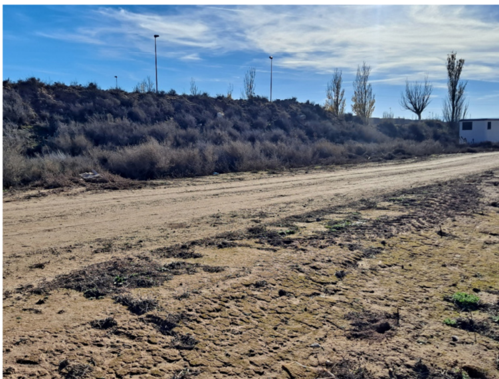
Figura 8.6. Tierra vegetal compactada, que apenas constituye ya un acopio, sino más bien un vial.
