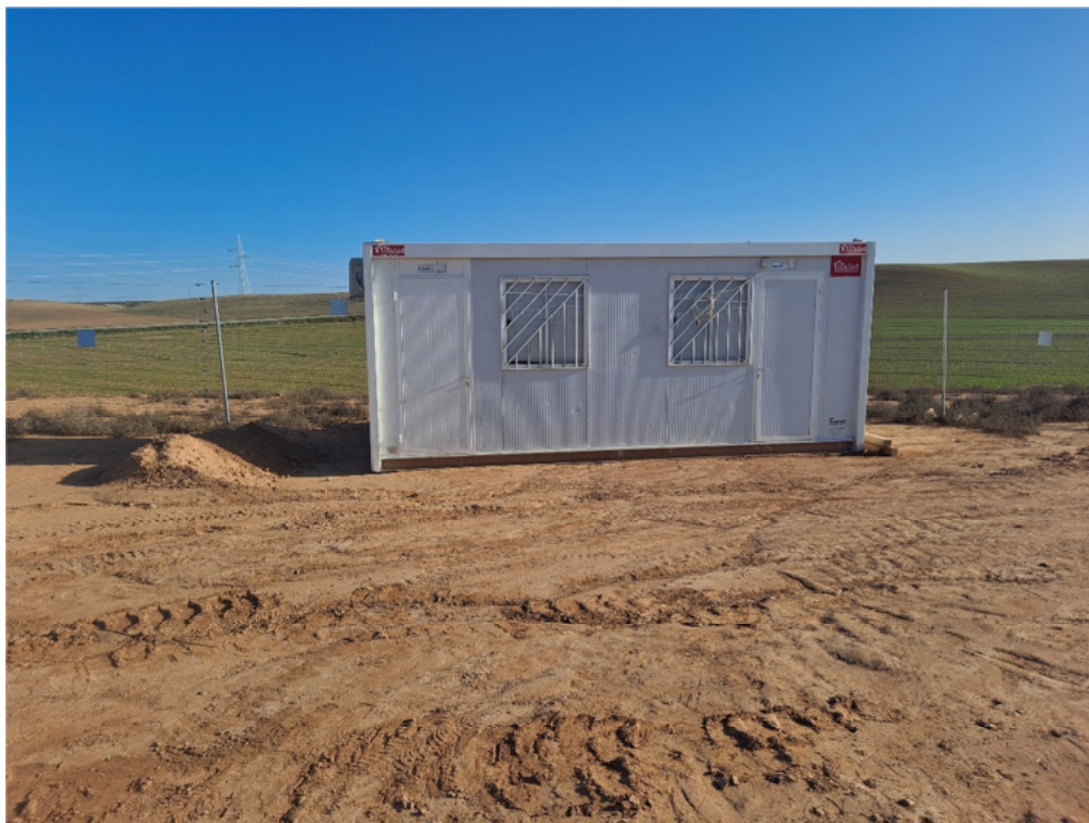
Figura 8.8. Caseta prefabricada instalada en el extremo norte del recinto
