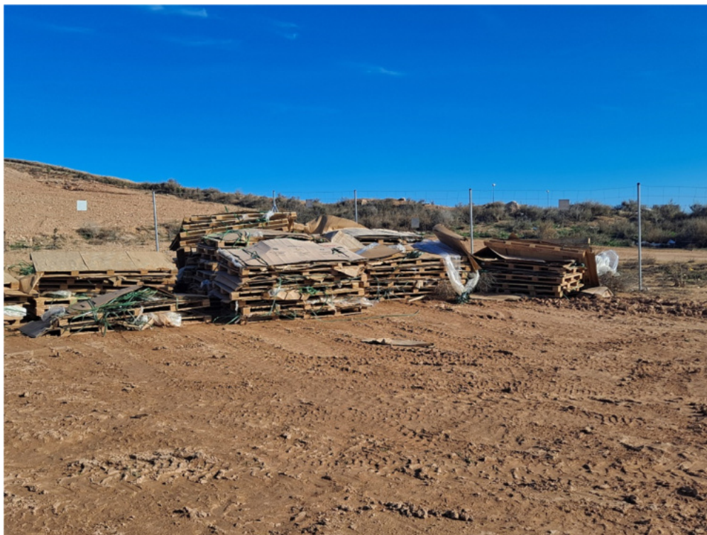
Figura 8.7. Acumulación de residuos en la esquina oriental de la planta, el 27-11-2024
