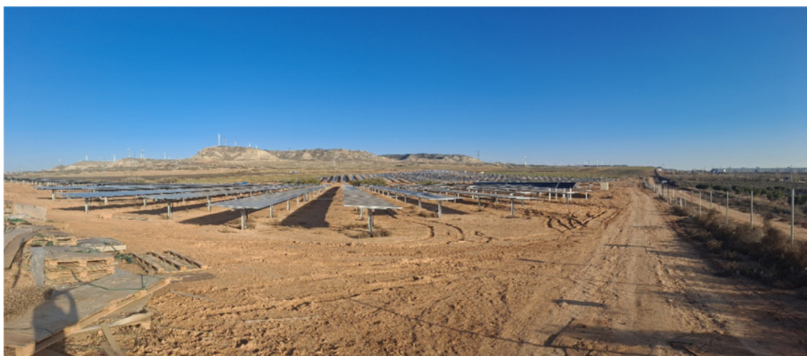
Figura 8.2. Aspecto de la planta el 18-12-2024. Se han abierto algunas zanjias interiores y se ha instalado una casete prefabricada
