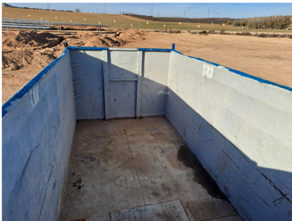
Figura 8.18. Segundo contenedor instalado, también vacío.
