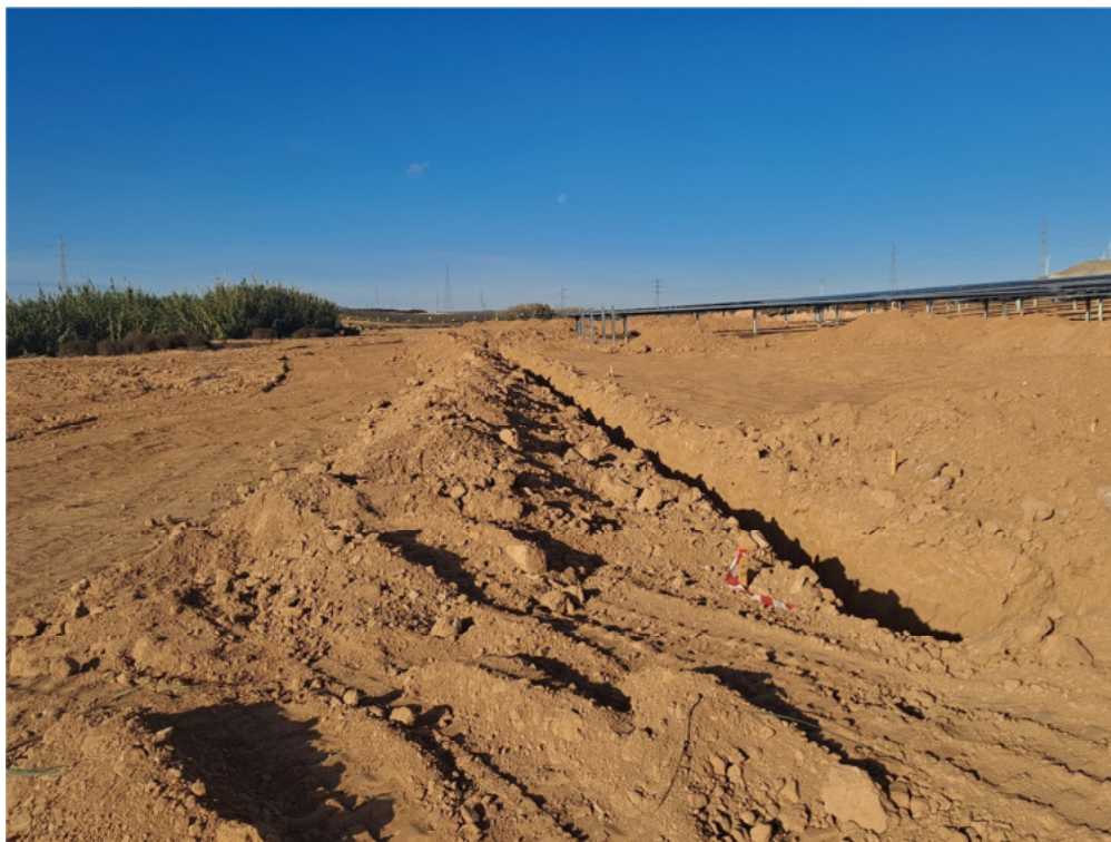
Figura 8.11. Zanjas abiertas en el interior del recinto vallado
