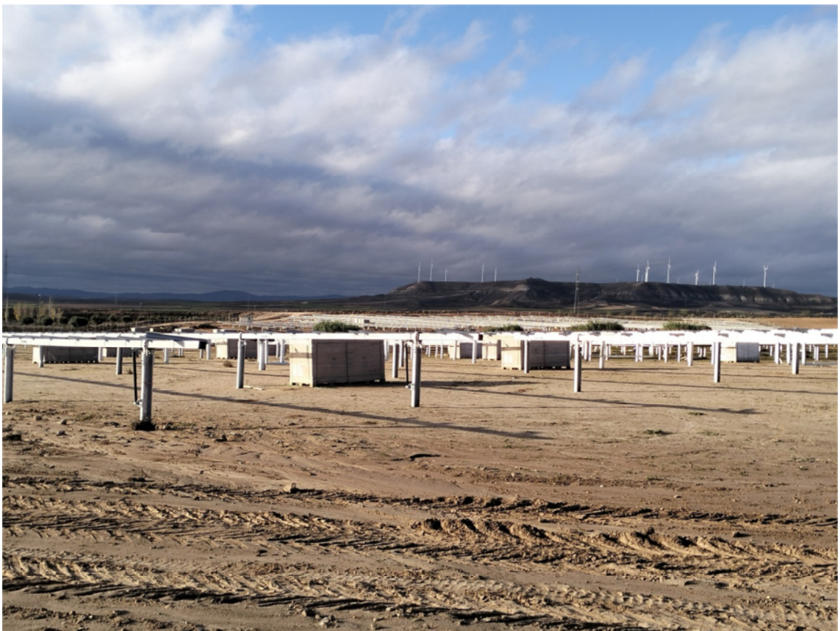
Figura 4.1. Aspecto de la parcela a fecha 31-10-2024, con seguidores colocados en la mitad norte de la planta.
