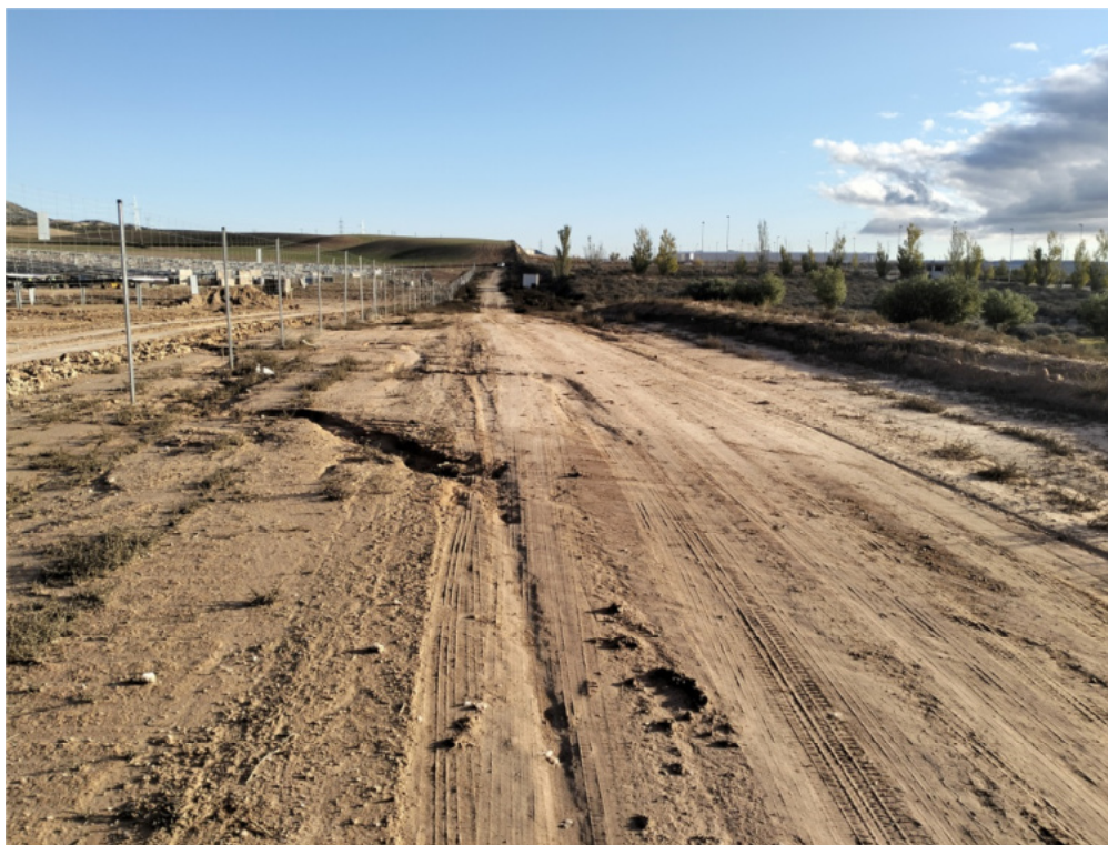
Figura 8.12. Regueros en el en perímetro exterior del sureste del vallado
