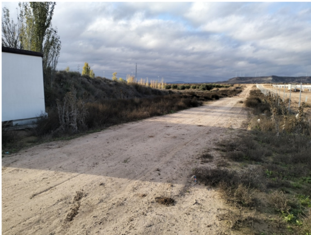
Figura 8.7. Aspecto del acopio situado en el extremo suroriental. Este tramo se usa como acceso, por lo que está compactado
