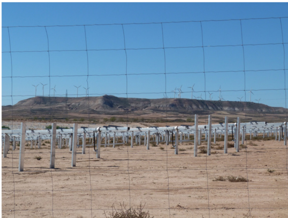
Figura 8.1. Aspecto de la planta el 30-09-2024. Se están colocando seguidores.
