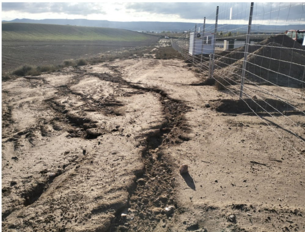
Figura 8.11. Regueros en el en perímetro exterior del norte del vallado
