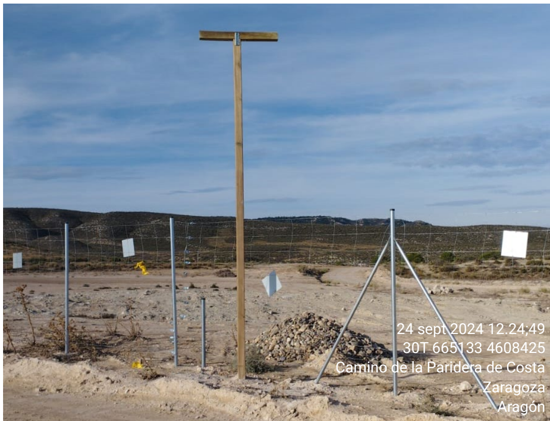
Ilustración 2. Instalación de postes posaderos y majanos para reptiles
