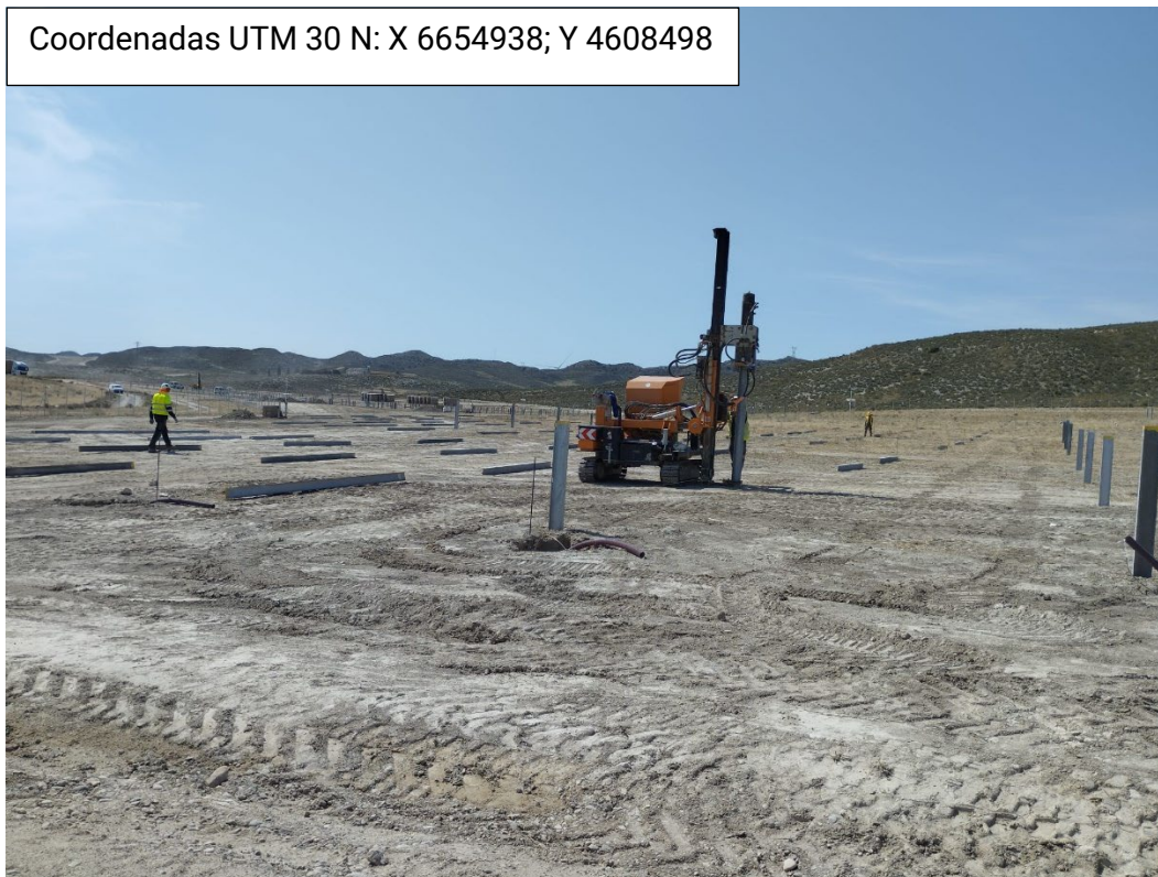
Ilustración 4. Proceso de hincado
