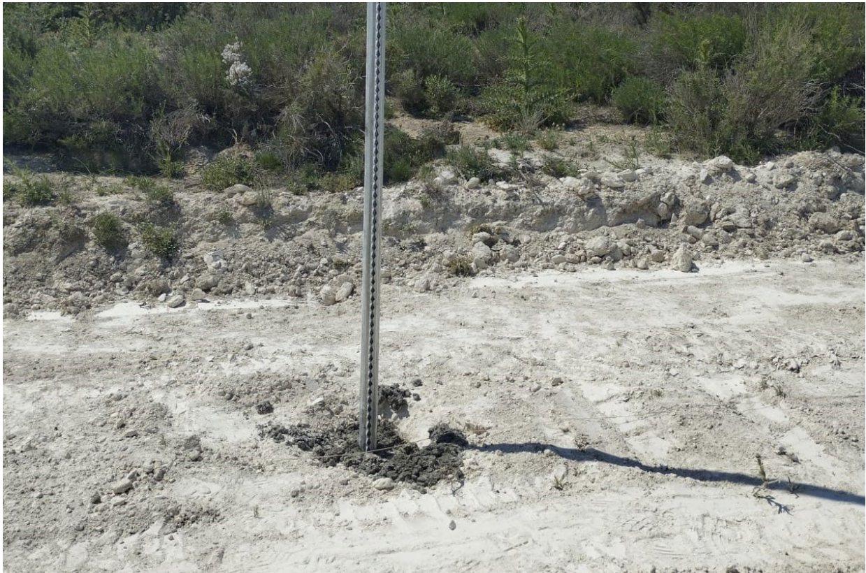
Imagen 4. Restos de hormigón junto a uno de los postes del vallado
