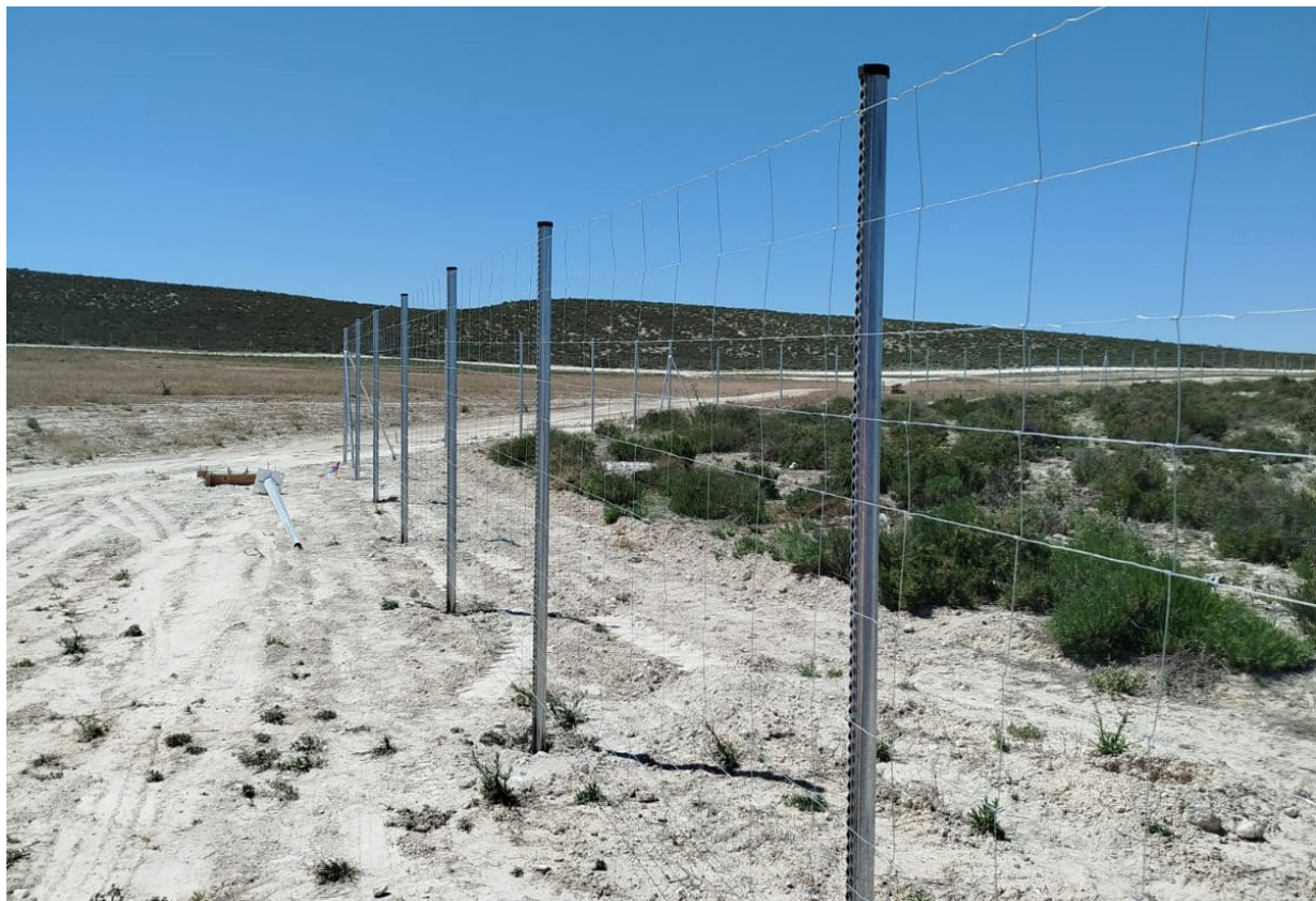
Imagen 6. Malla metálica del vallado tensada a falta de instalación de pacas anticolidión avifauna
