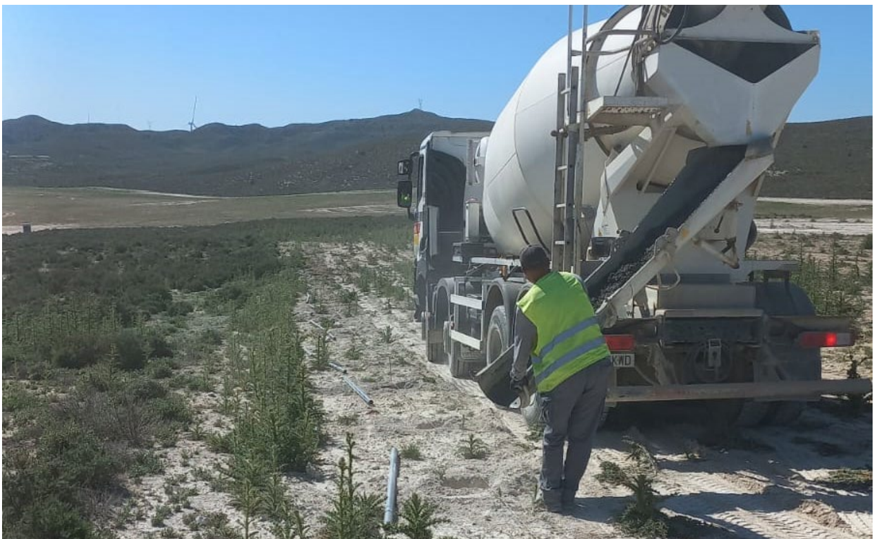
Imagen 2. Hormigonado postes del vallado
