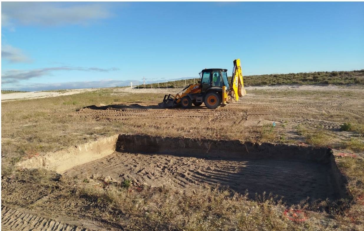
Imagen 8. Movimientos de tierra correspondientes a la excavación para la cimentación del CT.
