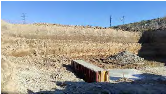
Fot 1-2. Ampliación y estratigrafía del foso de entrada para la zanja de evacuación junto a la vía del AVE.
