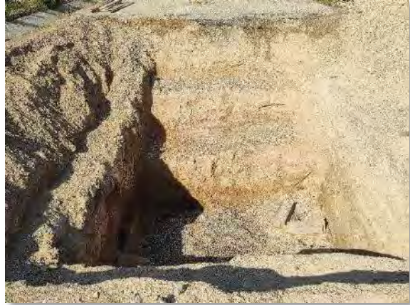
Fotografía 13: Excavación de los fosos de entrada y salida de la zanja de evacuación.
