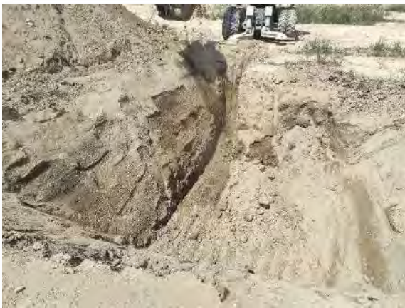
Fot 1-4. Excavación del foso de salida de la zanja de evacuación junto a la vía del AVE.
