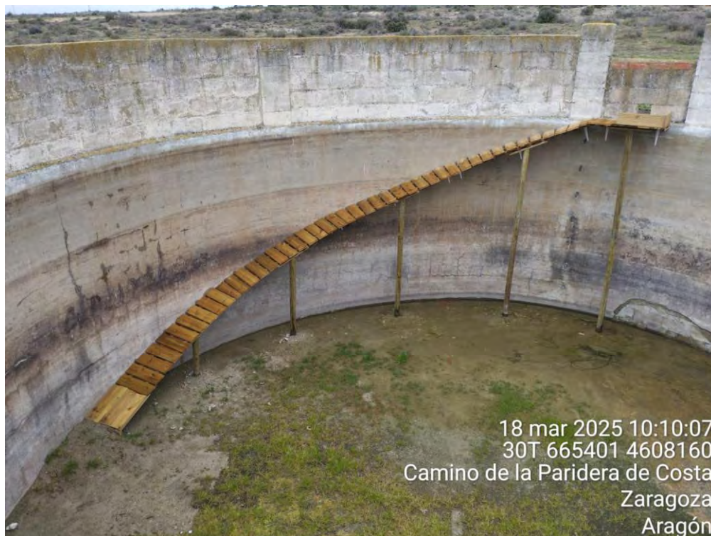
Ilustración 22. Rampa para fauna en aljibe existente
