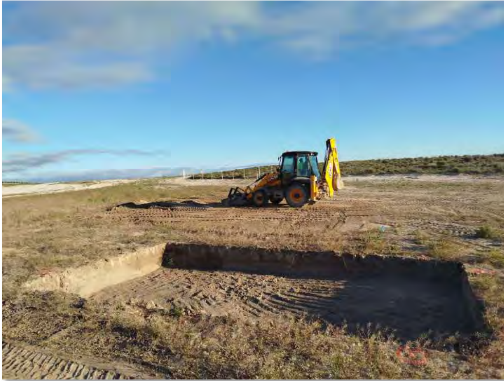
Fotografía 10: Excavación del CT en la PFV Mitra.
