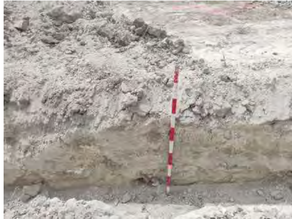
Fotografía 11: Excavación de las zanjas de BT y MT en el interior de la PFV Mitra.
