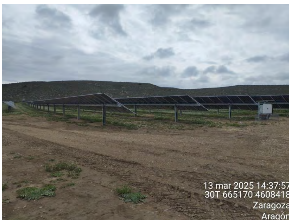
Ilustración 14. Limpieza total del entorno de la obra de restos y residuos
