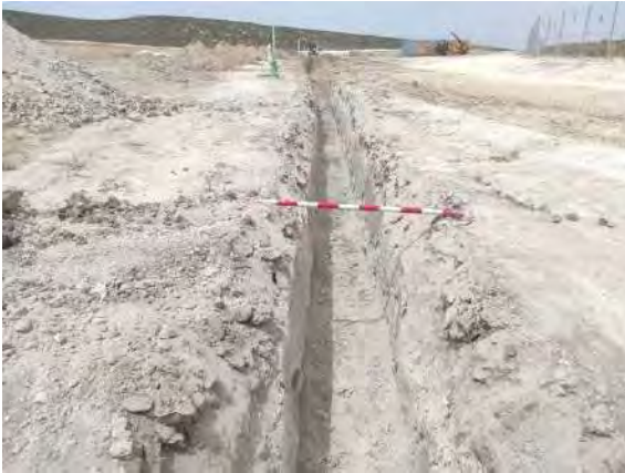
Fotografía 11: Excavación de las zanjas de BT y MT en el interior de la PFV Mitra.
