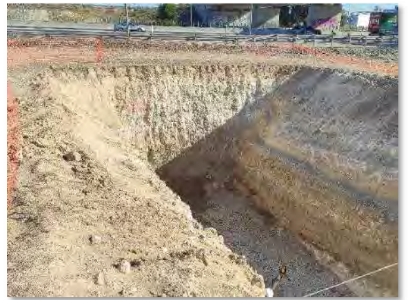
Fot 5-8. Excavación del foso de engrada de la zanja de evacuación junto a la A-2.
