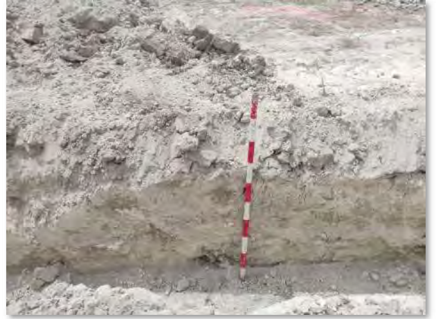
Fot 1-6. Ejecución de la zanja de interconexión en el interior de la PFV Mitra
