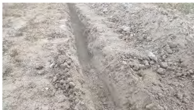
Fot 1-2. Ejecución de la zanja de interconexión (MT) en el interior de la PFV Mitra
