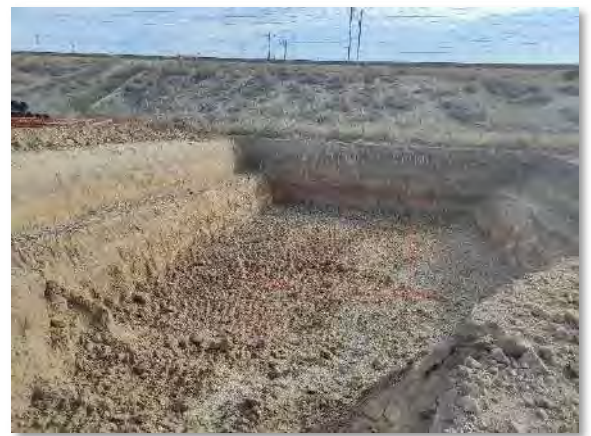
Fot 1-4. Ejecución de la entrada de la zanja de evacuación junto a la vía del AVE.
