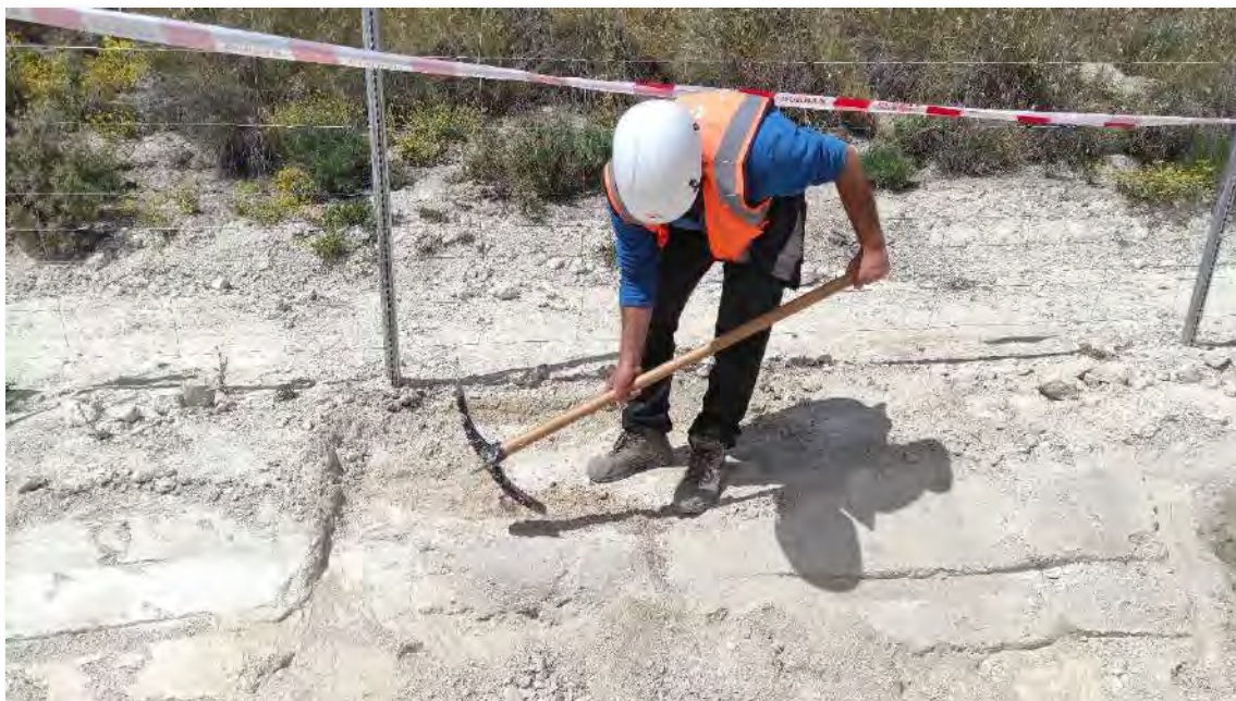
Fot. 3. Proceso de apertura en planta de la estructura negativa documentada en el perfil de la de cuneta de evacuación de aguas.
