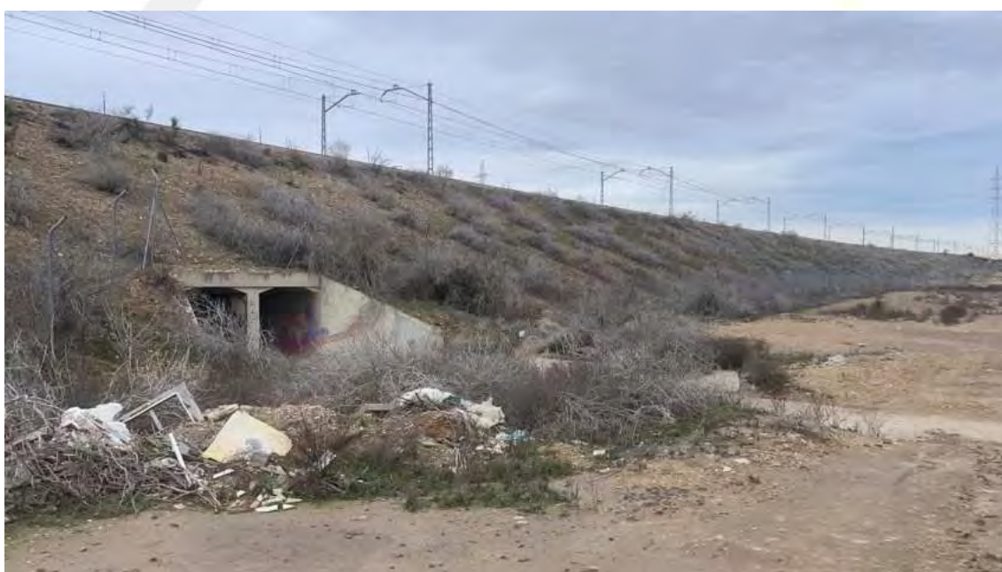
Ilustración 52. Fotografías tomadas del entorno del punto de observación 22. Fuente: elaboración propia.
