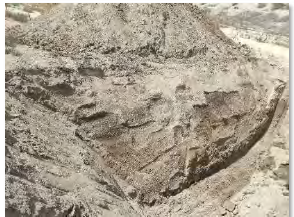
Fot 1-4. Excavación del foso de salida de la zanja de evacuación junto a la vía del AVE.
