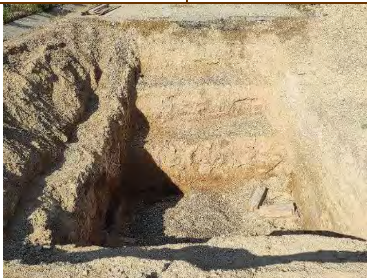
Fot 1-3. Excavación del foso de salida de la zanja de evacuación junto a la A-2.
