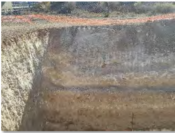
Fot 5-8. Excavación del foso de engrada de la zanja de evacuación junto a la A-2.
