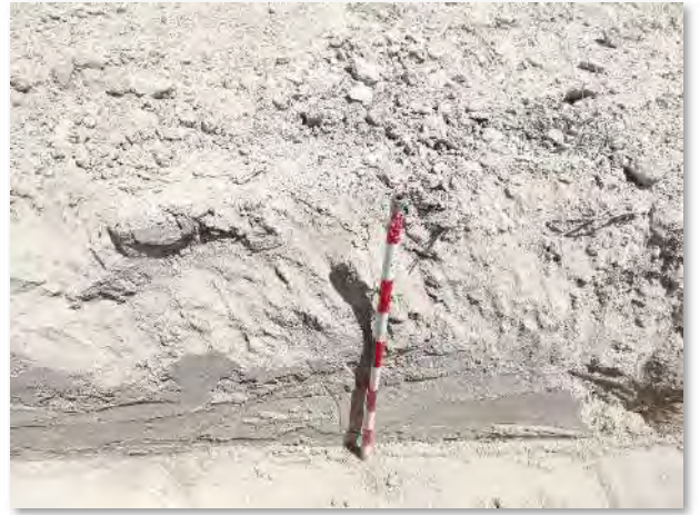
Fot 1-6. Ejecución de la zanja de interconexión en el interior de la PFV Mitra (Sector Norte)
