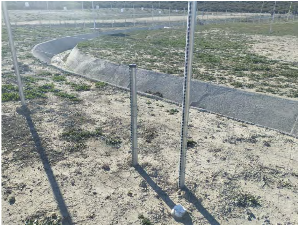
Ilustración 5. Pasos de fauna en el vallado perimetral
