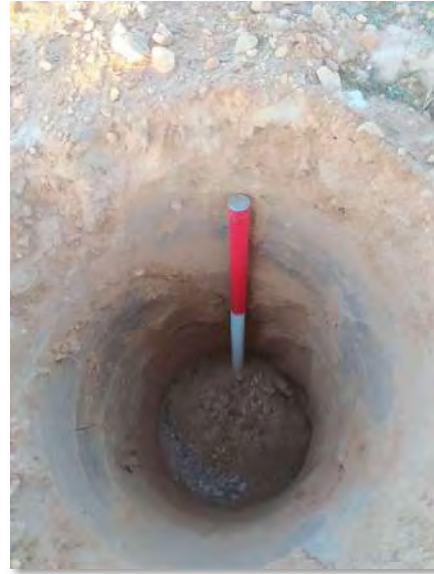
Fotografía 1: Ejecución del Vallado Perimetral para la PFV Mitra.
