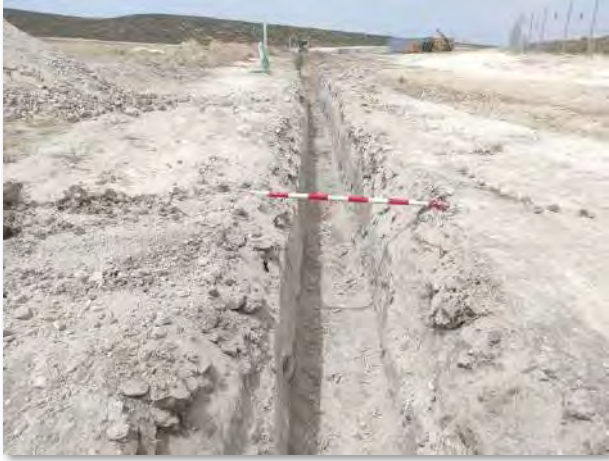
Fot 1-6. Ejecución de la zanja de interconexión en el interior de la PFV Mitra
