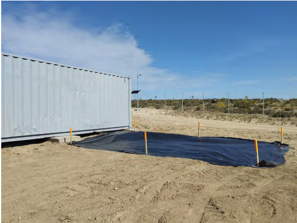
Ilustración 6. Aparcamiento impermeabilizado para maquinaria
