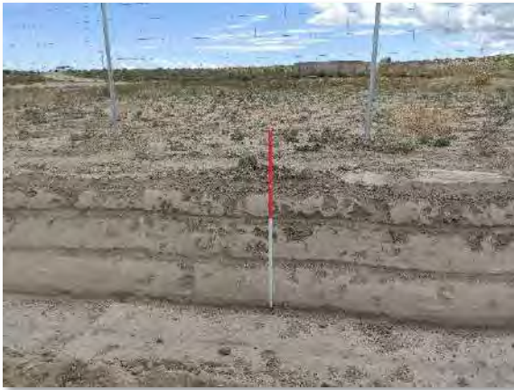
Fotografía 4: Excavación de las cunetas perimetrales de la PFV Mitra.
