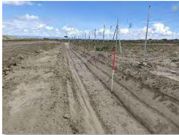
Fotografía 4: Excavación de las cunetas perimetrales de la PFV Mitra.
