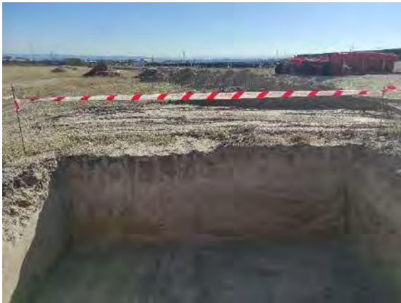
Fot 1-2. Ampliación y estratigrafía del foso de entrada para la zanja de evacuación junto a la vía del AVE.
