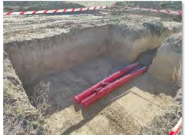
Fot 1-2. Ampliación y estratigrafía del foso de entrada para la zanja de evacuación junto a la vía del AVE.
