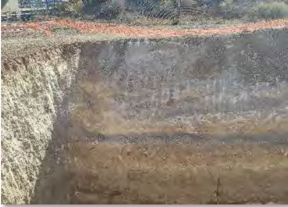
Fotografía 13: Excavación de los fosos de entrada y salida de la zanja de evacuación.
