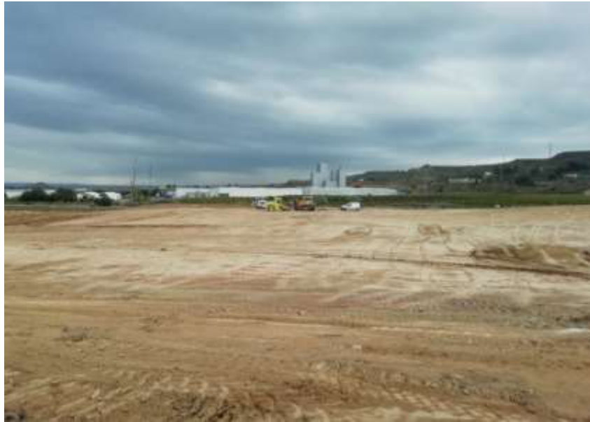
Figura 3. Movimientos de tierra.
