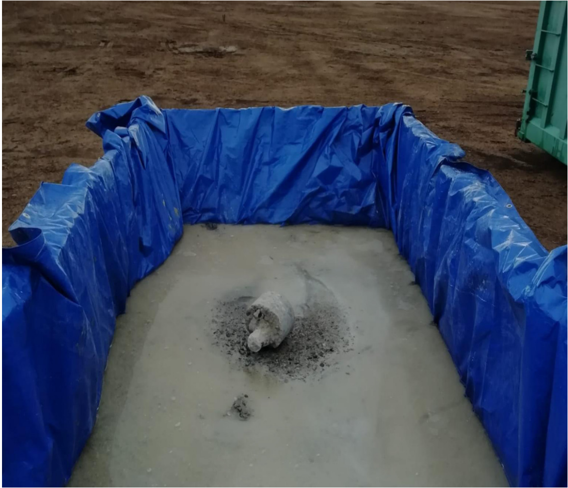
Figura 2. Contenedor de residuos de cemento.
