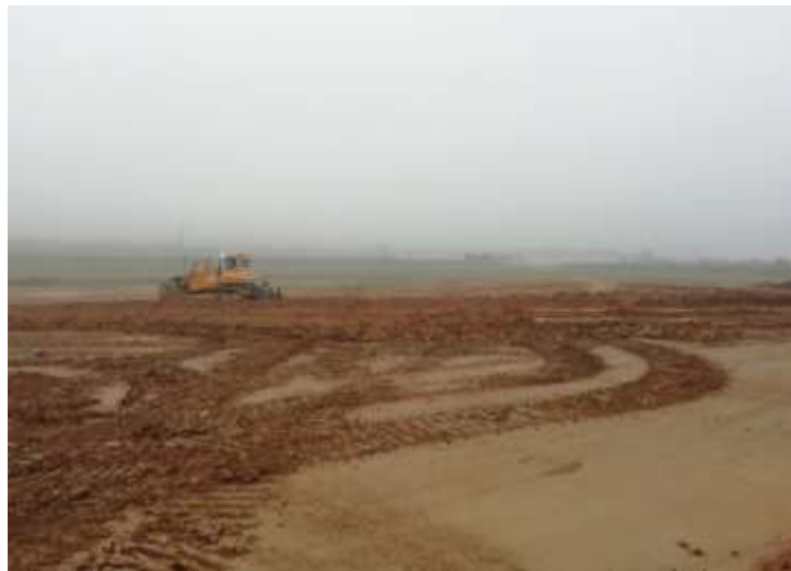
Figura 2. Movimientos de tierra.
