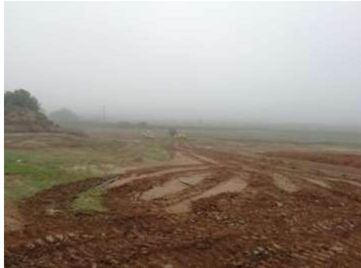
Figura 1. Movimientos de tierra.
