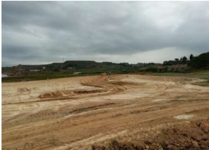
Figura 4. Movimientos de tierra.
