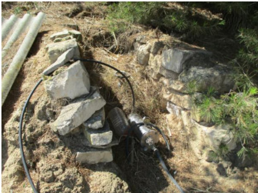
Imagen 18: Parcela 2, Pol. 21 construcción de mampostería en piedra seca
