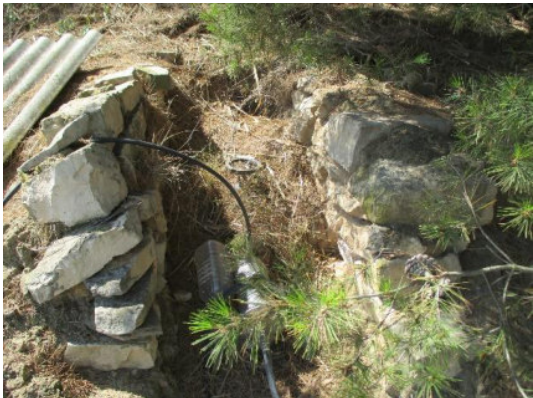
Imagen 17: Parcela 2, Pol. 21 construcción de mampostería en piedra seca
