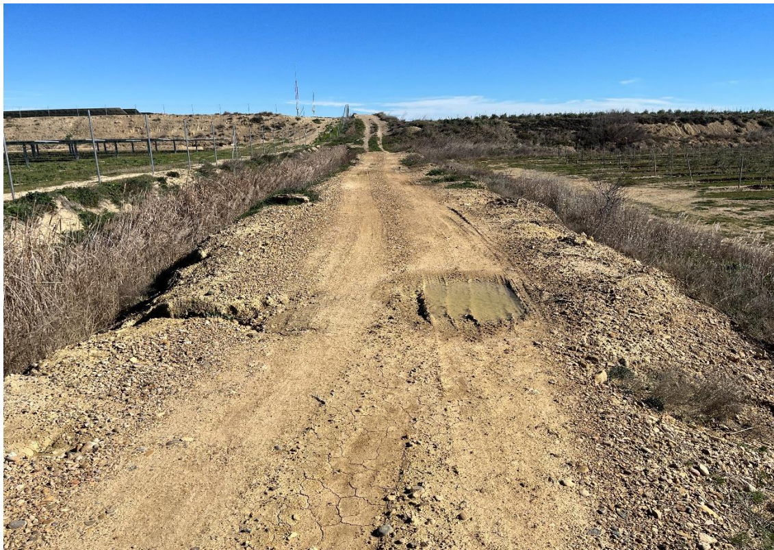
Fotografía 13. Erosión considerable en uno de los caminos que comprenden el transecto. Marzo 2024.
