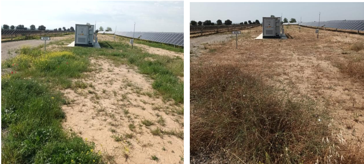
Zona del centro de transformación en abril (izquierda) y junio (derecha)
