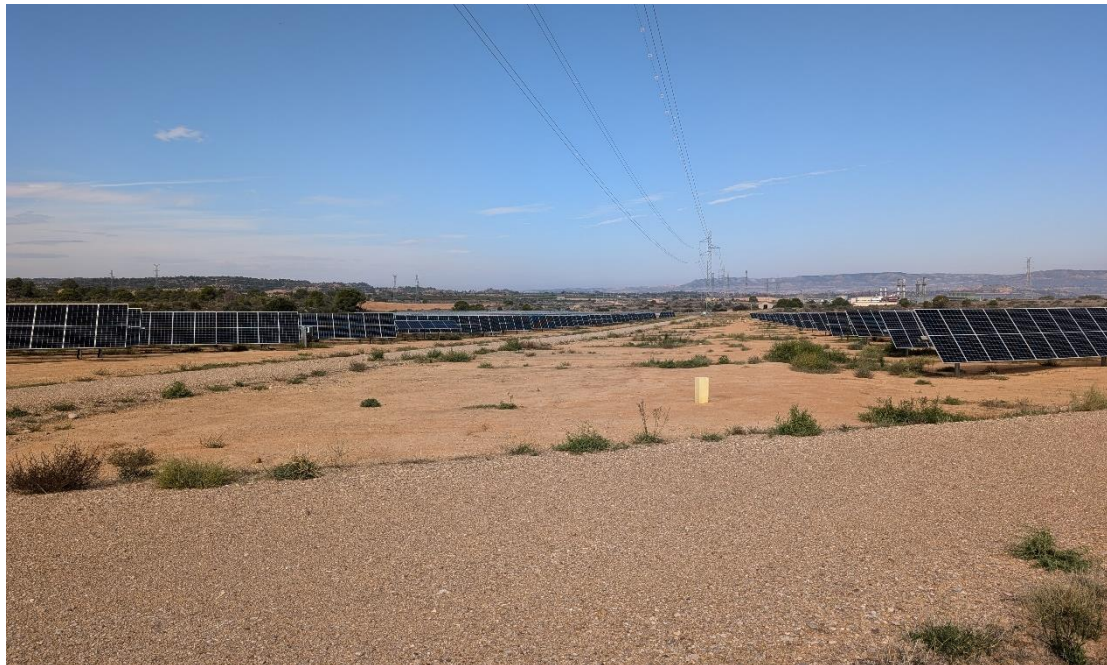
Foto 4. Vista desde el vallado perimetral de la planta. Apreciación de la calle principal del recinto noroeste.
