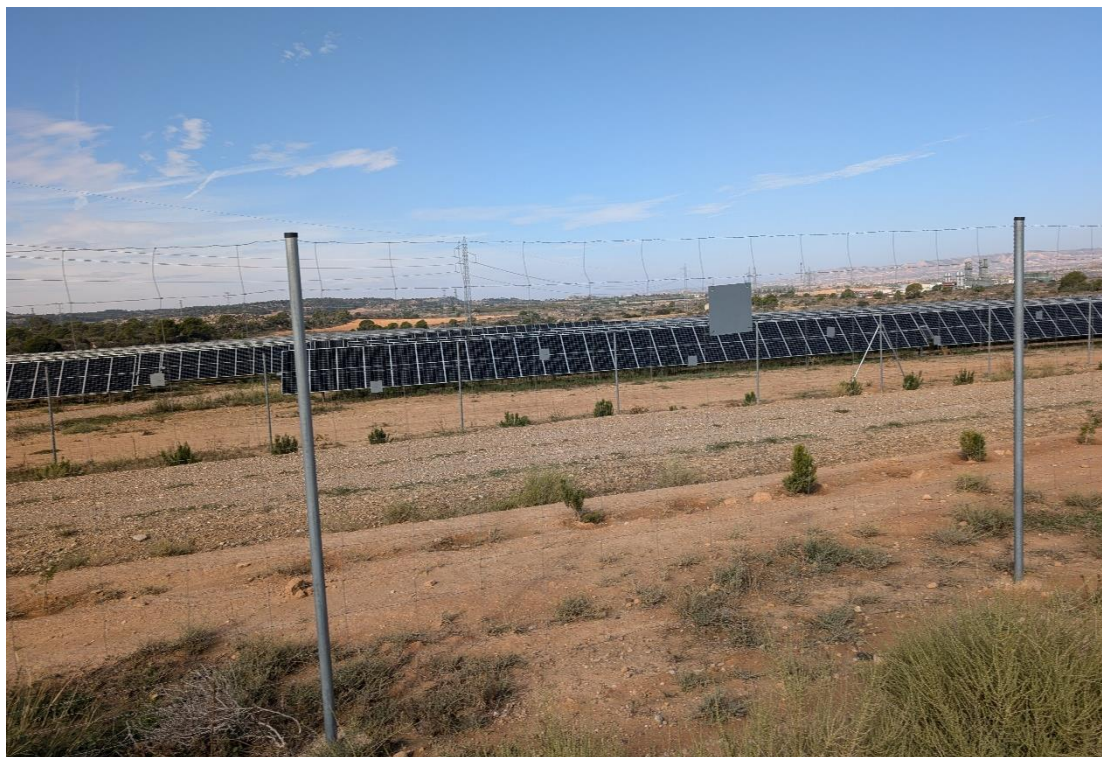
Foto 1. Vista del vallado perimetral de la planta en dos de los recintos con el Camino Natural del Ebro entre ellos. Apreciación de las placas a tresbolillo a lo largo de vallado.
