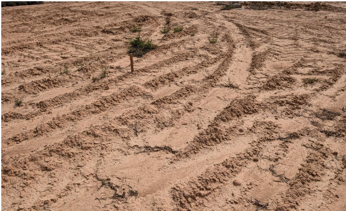
Foto 23. Rodadas en zona de trabajo de sustitución de estructura fija por seguidores
