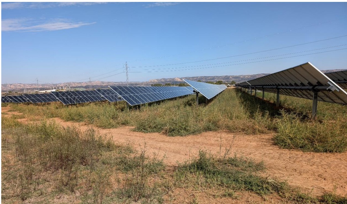
Foto 11. Vista de seguidores en la zona con una cubierta vegetal mayor. Se aprecia la franja utilizada para circulación de vehículos.
