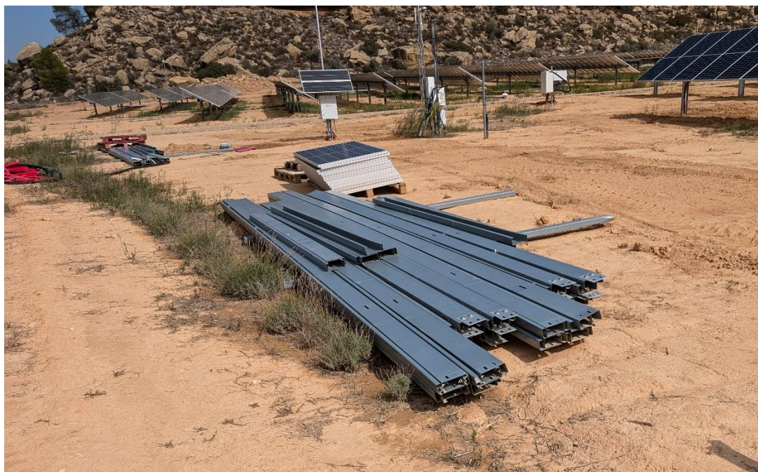
Foto 21. Acopio de estructura metálica, tubos corrugados para circuitos eléctricos y paneles para el montaje de nuevos seguidores procedente de la retirada de paneles de estructura fija
