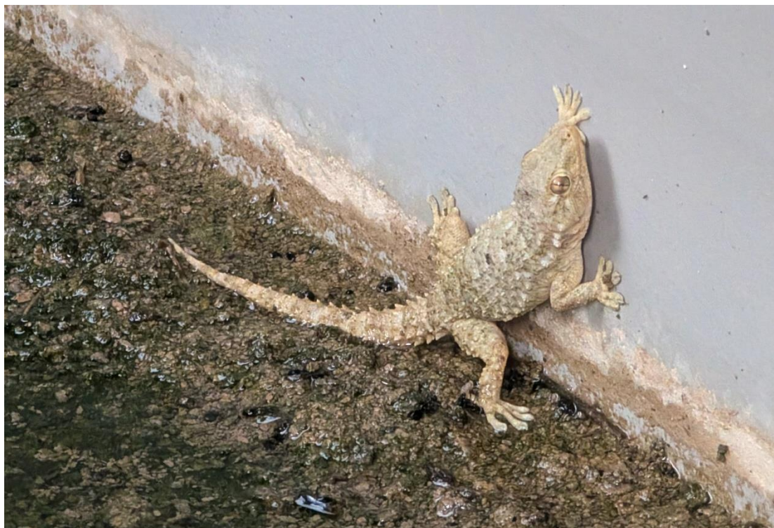
Foto 9. Detalle de la cubeta del centro de transformación con u ejemplar de salamandresa común.
