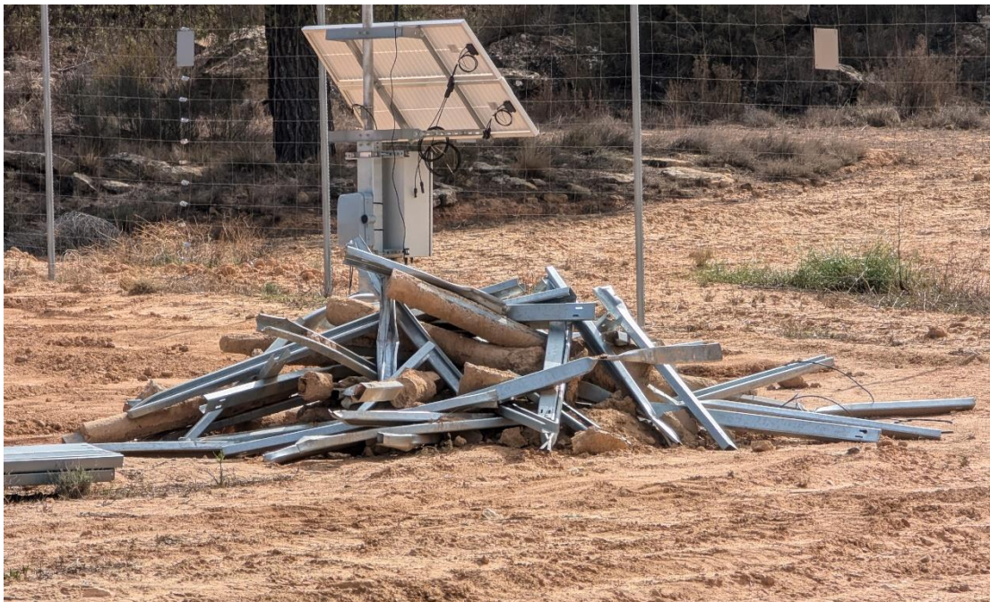
Foto 19. Acopio de estructura metálica procedente de la retirada de paneles de estructura fija
