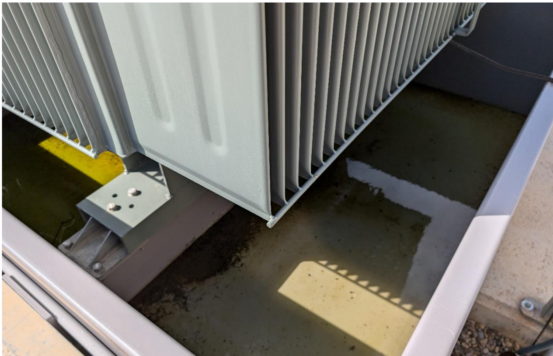
Foto 8. Vista de la cubeta del centro de transformación con agua de las recientes lluvias. Estado limpio salvo por la presencia de algunos restos de origen vegetal llevados por el viento.
