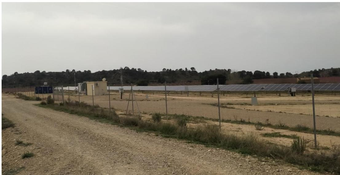
*Foto 1. Vista del vallado perimetral de la planta. Apreciación de las placas a tresbolillo a lo largo de vallado.*
