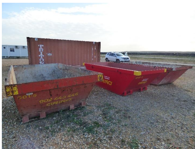
Imagen 18. Contenedores de obra habilitados para el depósito de residuos no peligrosos
