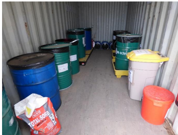
Imagen 20. Depósitos homologados adecuadamente identificados situados en el interior del punto limpio para el depósito temporal de residuos peligrosos
