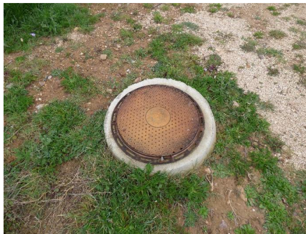
Imagen 4. Tapa de acceso al depósito estanco, sin evidencias de desbordamientos
