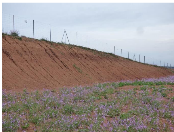
Imagen 3. Talud Sur de la planta fotovoltaica
