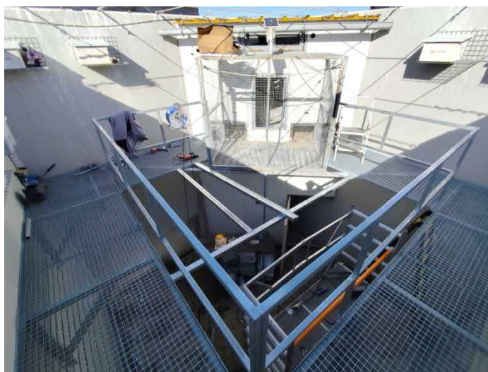
Montaje de la nueva primera planta
