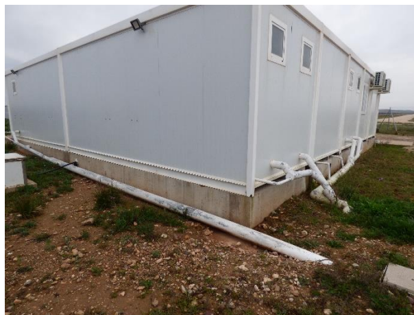
Imagen 5. Tuberías de salida de las aguas residuales de los aseos del edificio de O&M, sin evidencias de desbordamientos
