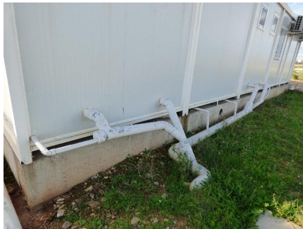
Imagen 5. Tuberías de salida de las aguas residuales de los aseos del edificio de O&M, sin evidencias de desbordamientos
