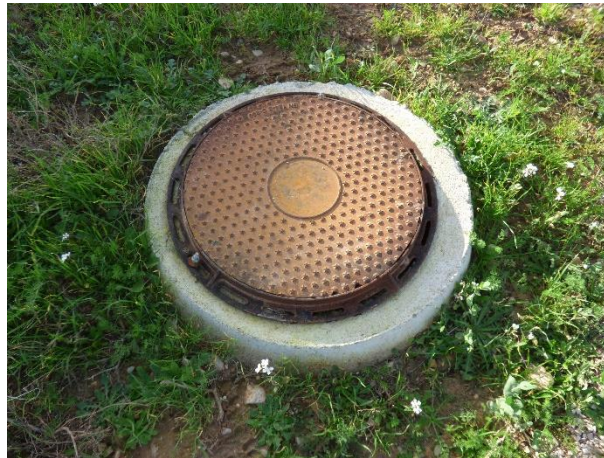
Imagen 4. Tapa de acceso al depósito estanco, sin evidencias de desbordamientos
