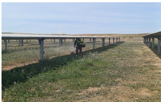
Imagen 5. Operario desbrozando la vegetación natural situada bajo los paneles solares
