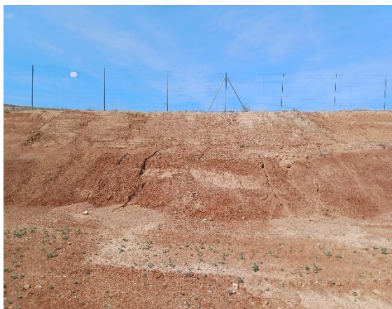
Imagen 1. Procesos erosivos en el talud situado al sur de la planta fotovoltaica de "Híjar I"
