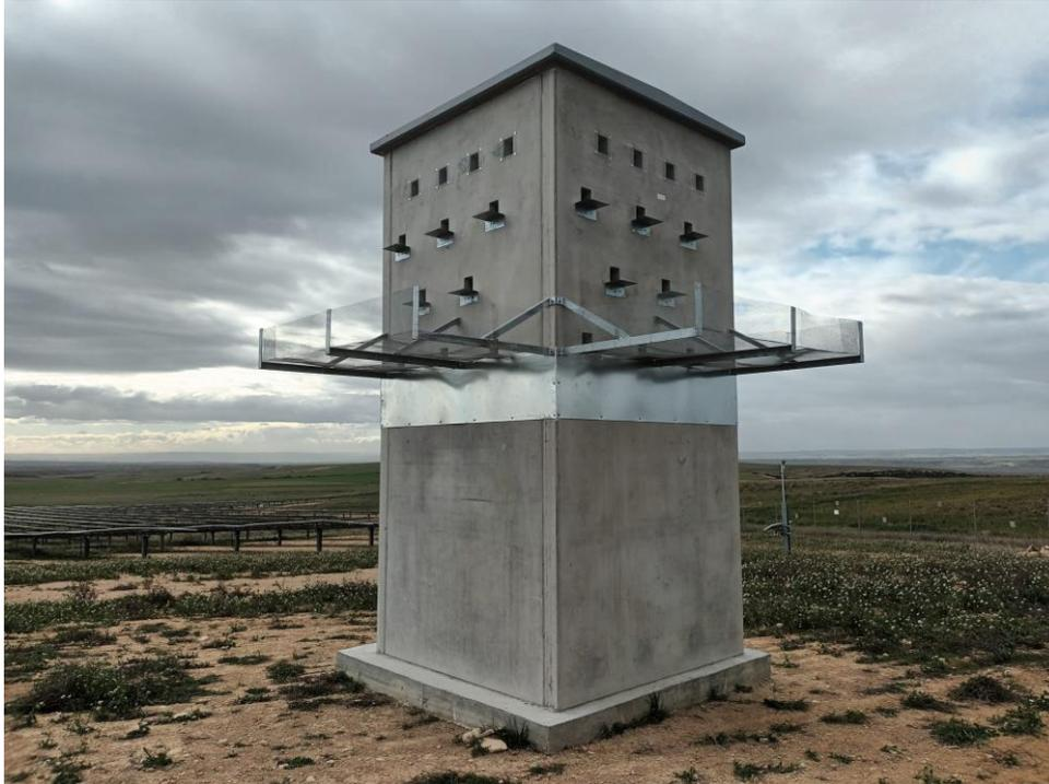
Primillar construido en el interior de la planta, con modificaciones como la chapa antipredación o el sistema anti-caídas.
