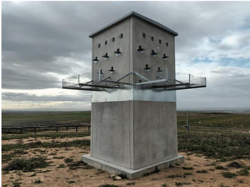
Arriba, aspecto del primillar una vez instalados la chapa antipredación y el sistema anticaídas. Abajo, detalle de las cajas instaladas.
