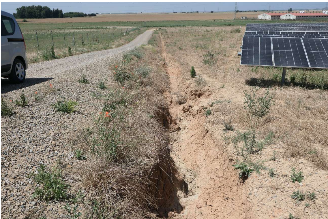
Imagen 12.- Zanja de drenaje en punto de cota más baja.
