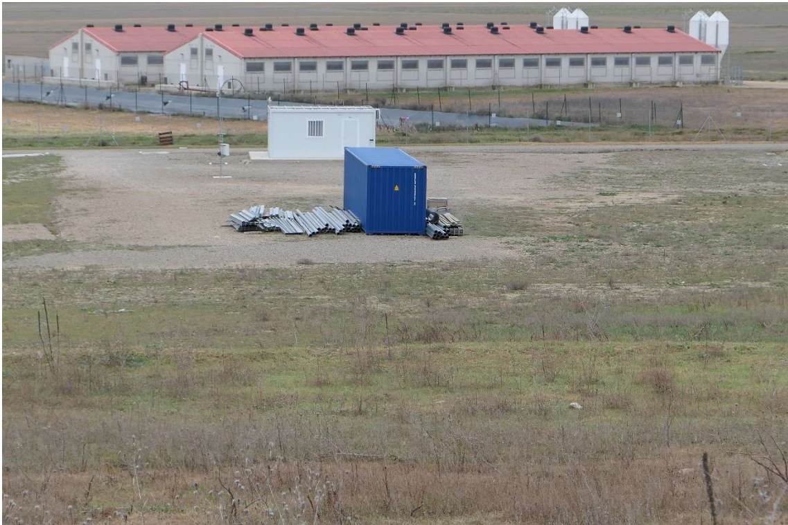
Imagen 7.- Área de deposición de residuos y materiales de obra y repuesto. Detrás, caseta de control. Al fondo, granja de porcino próxima.
