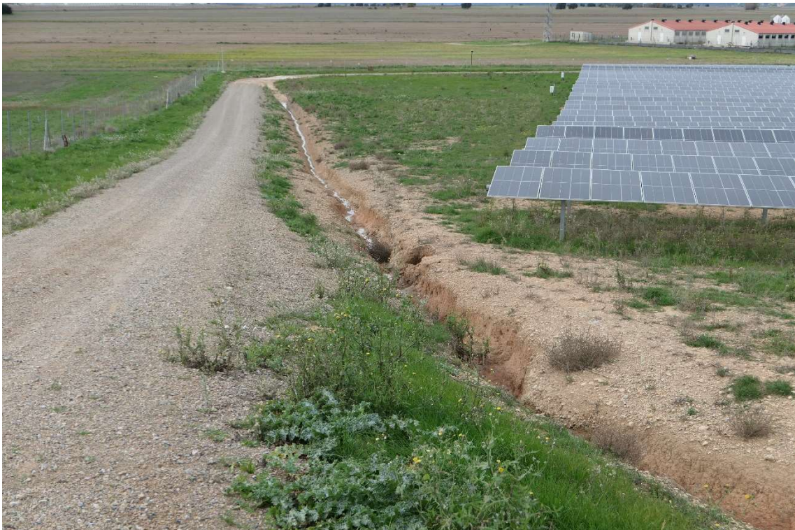
Imagen 12.- Zanja de drenaje.
