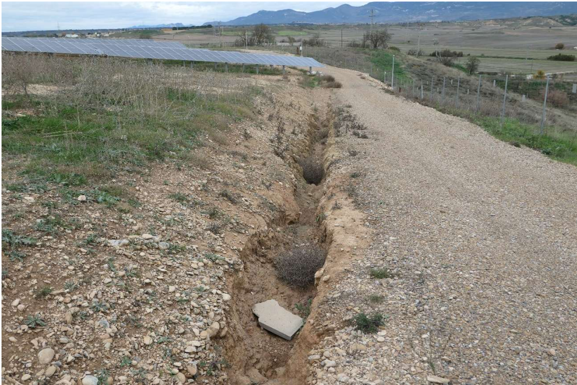
Imagen 11.- Zanja de drenaje.
