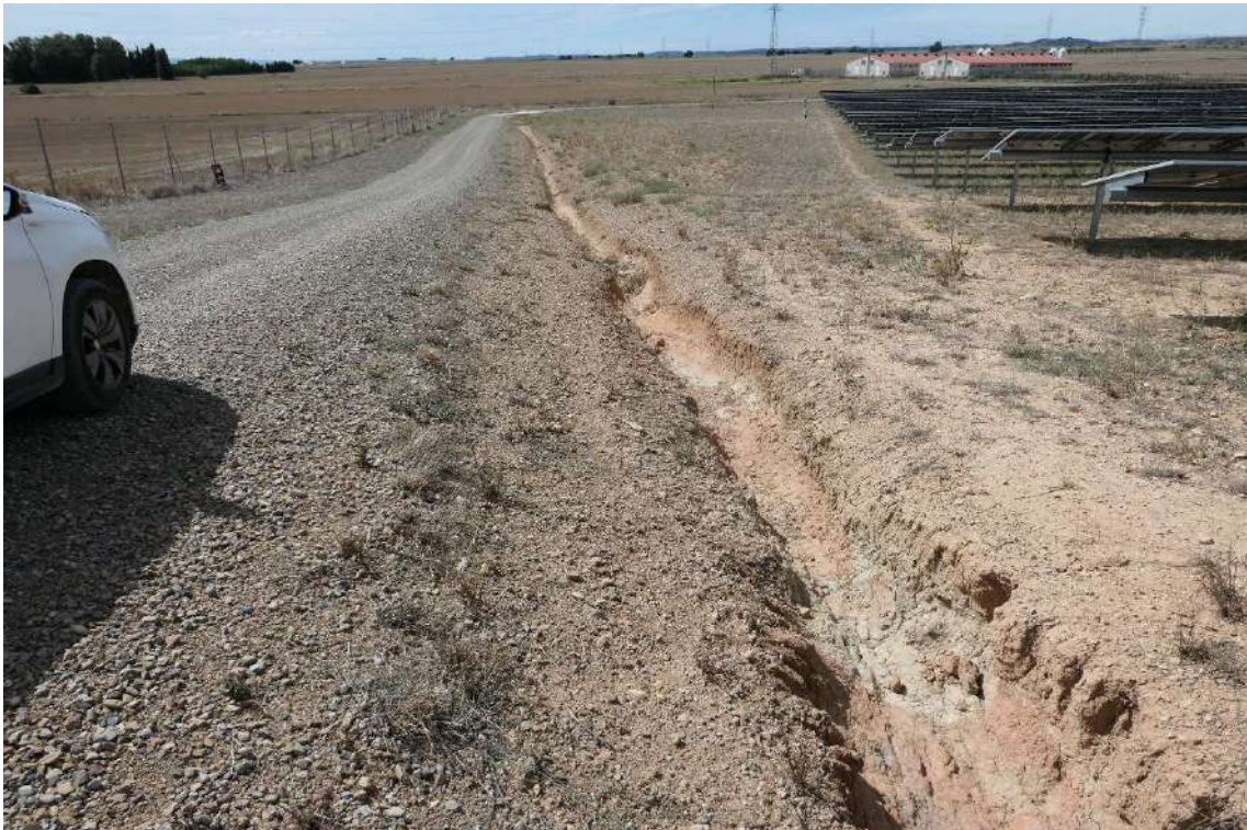
Imagen 8.- Zanja de drenaje.
