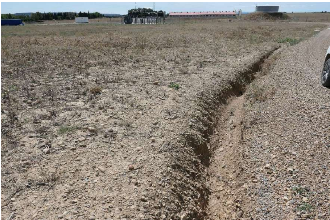
Imagen 10.- Zanja de drenaje.
