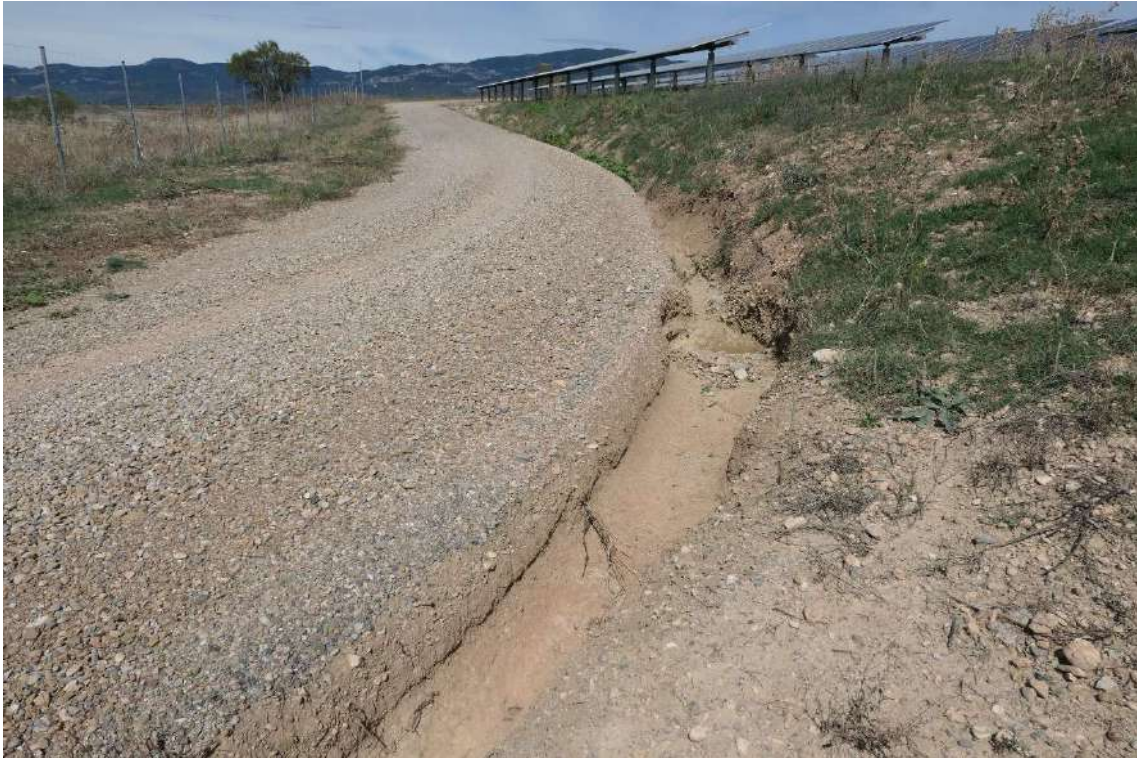
Imagen 9.- Zanja de drenaje.
