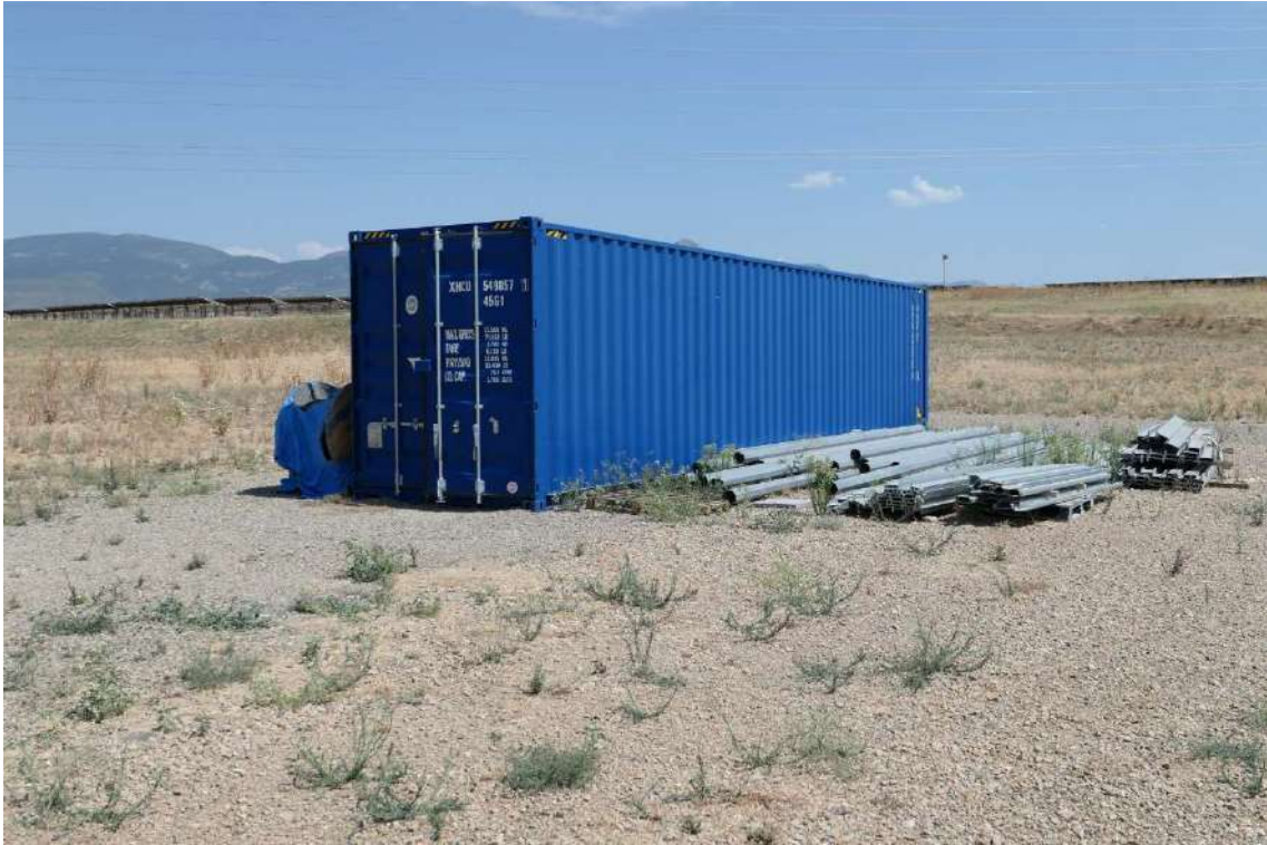
Imagen 7.- Área de deposición de residuos y materiales de obra y repuesto.
