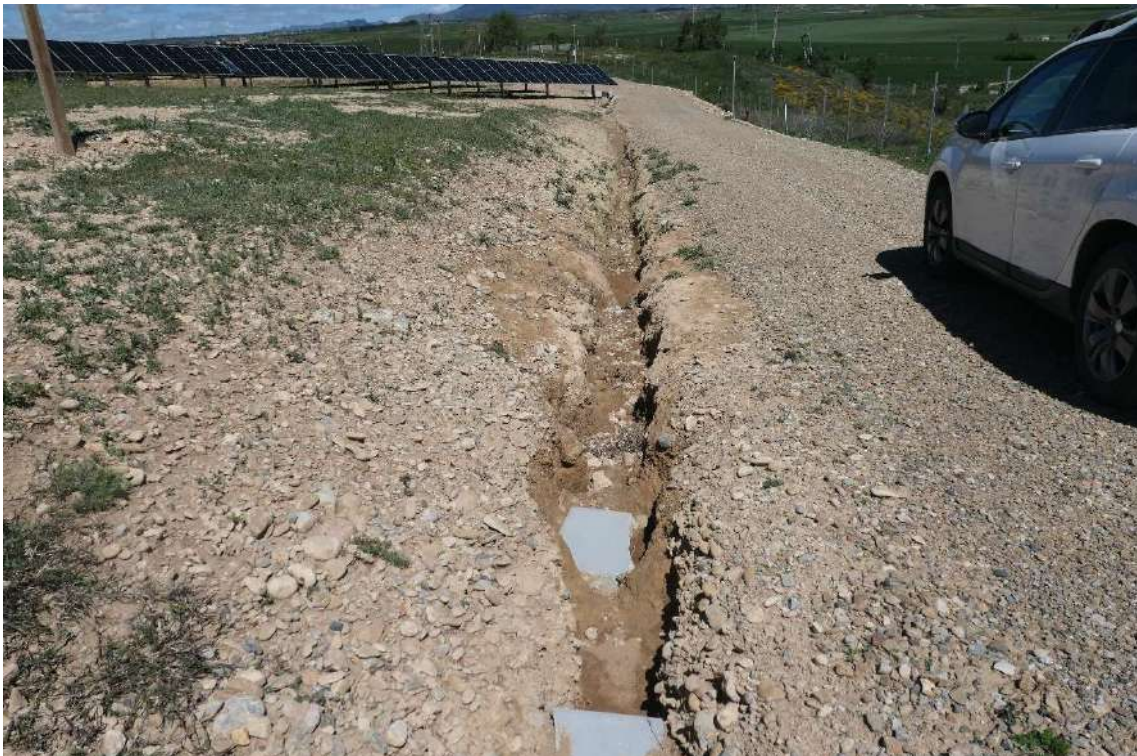
Imagen 4.- Cuneta de drenaje de escorrentías. A pesar de las lluvias persistentes ocurridas, se mantienen en muy buen estado.
