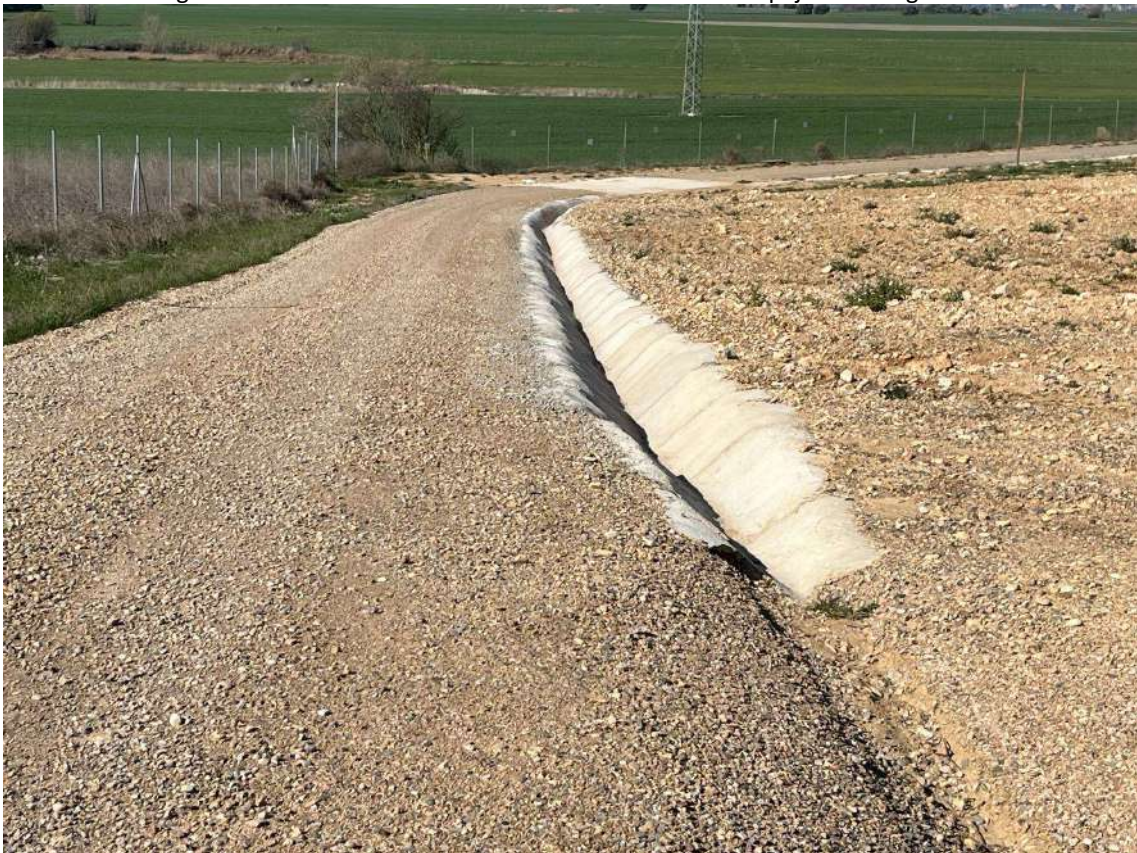
Imagen 20.- Control de la erosión, cunetas hormigonadas
