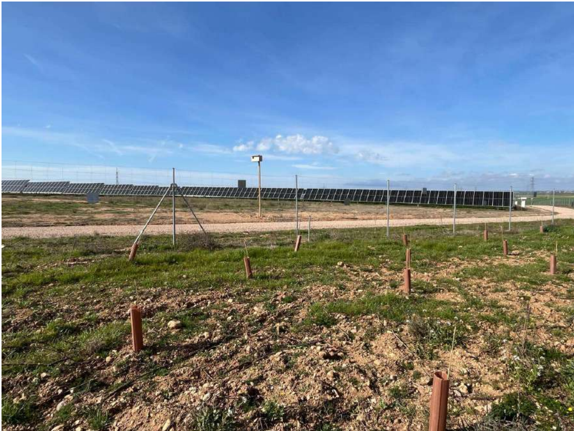
Imagen 15.- Zona de repoblación forestal (apantallamiento vegetal), vallado y planta solar.
