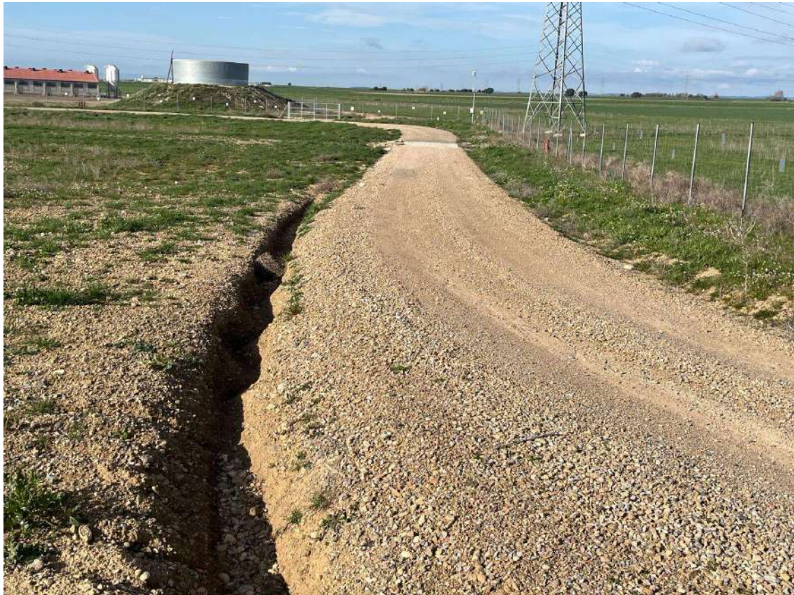
Imagen 3.- Cunetas y camino en buen estado.
