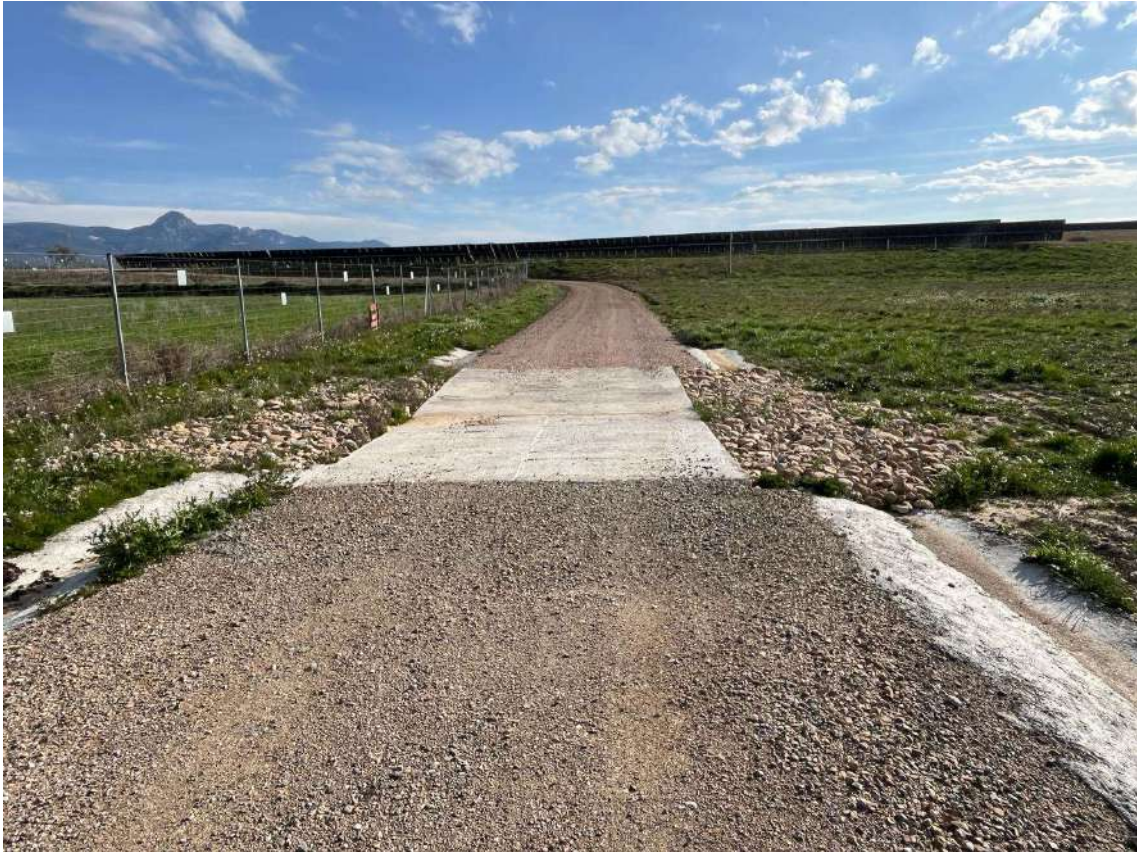
Imagen 5.- Control hidrológico, cunetas y badén. Vallado con placas señaladoras.
