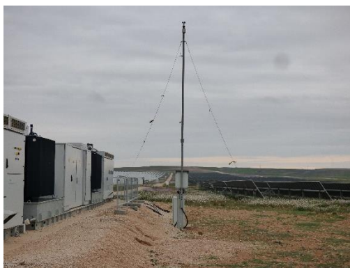
Imagen 7. Periódicamente el promotor revisa las cintas de plástico instaladas en los sensores de las torres anemométricas cuya finalidad es incrementar la visibilidad de los mismos por parte de la avifauna
