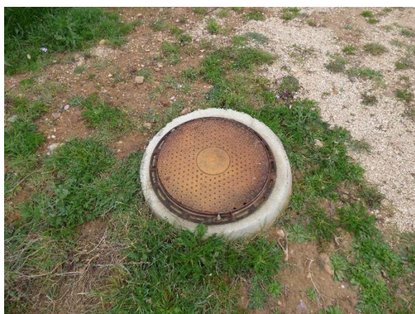
Imagen 3. Tapa de acceso al depósito estanco, sin evidencias de desbordamientos
