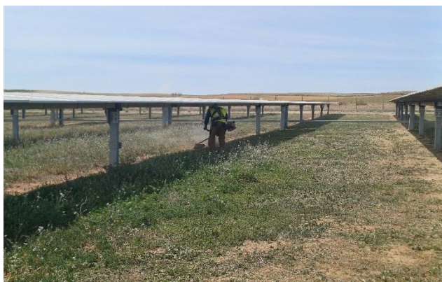
Imagen 4. Operario desbrozando la vegetación natural situada bajo los paneles solares
