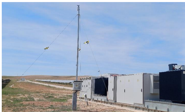
Imagen 7. Periódicamente el promotor revisa las cintas de plástico instaladas en los tensores de las torres anemométricas con el objetivo de incrementar la visibilidad de los mismos por parte de la avifauna
