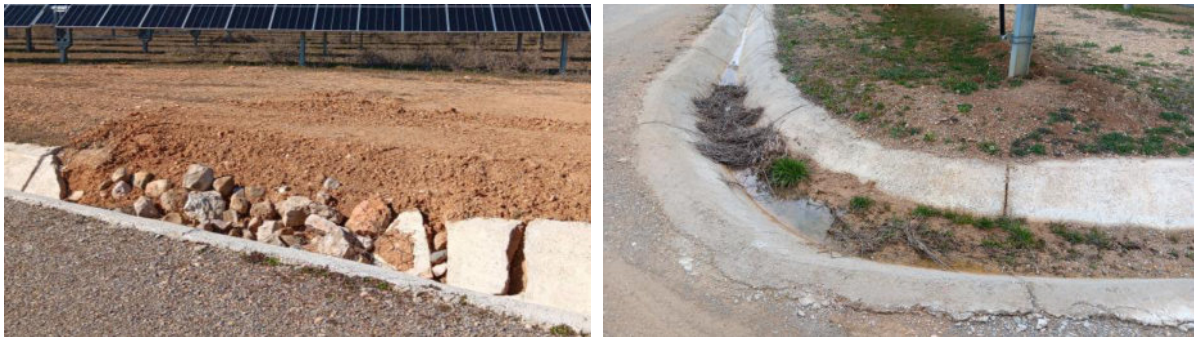
Drenajes con material en el mes de febrero y marzo en la parcela 1 (izq) y 4 (dch).
