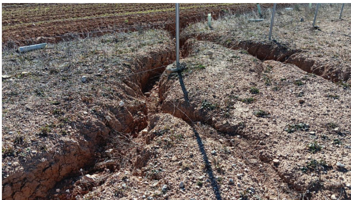
Surcos erosivos asociados a vallado en la parcela 7 en enero.
