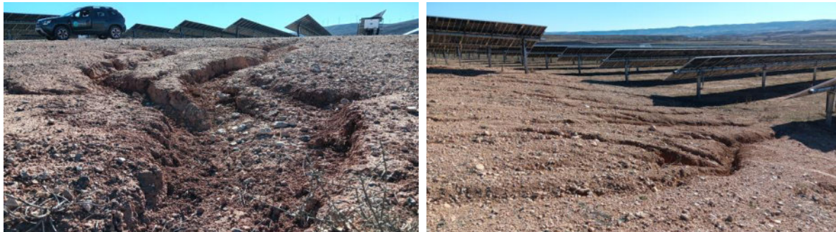
Surcos de erosión de la parcela 4 en enero.
