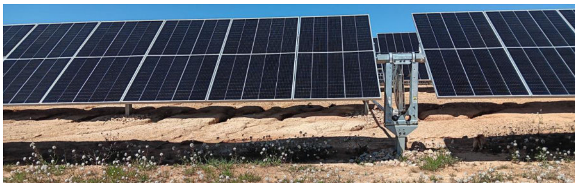
Surcos erosivos bajo módulos en la parcela 1 en abril.
