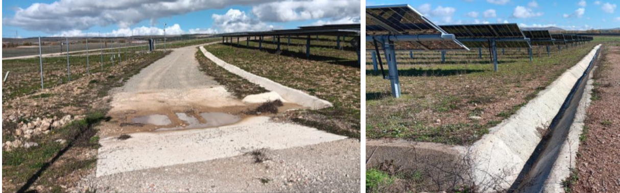
Drenajes limpios de material en el mes de noviembre en la parcela 2 (izq) y parcela 5 (dch).
