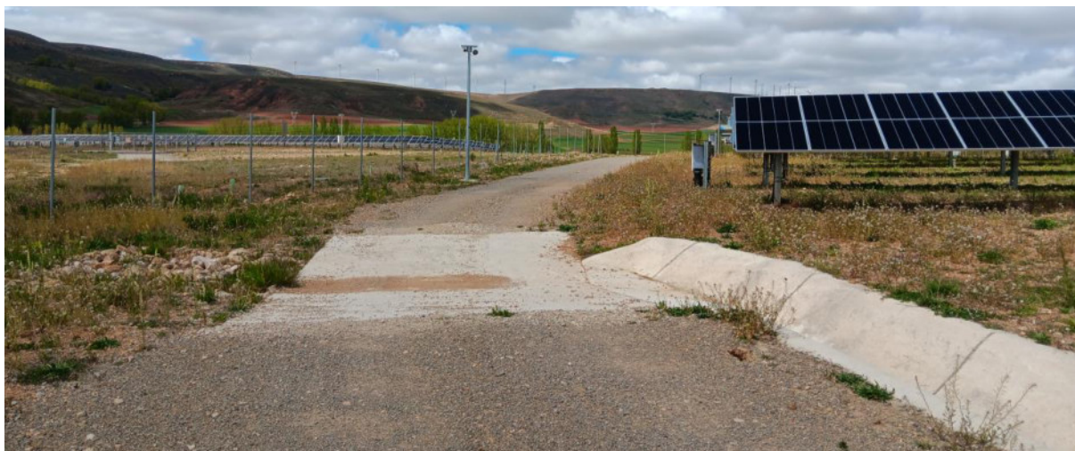
Drenajes limpios de material en el mes de mayo en la parcela 2.
