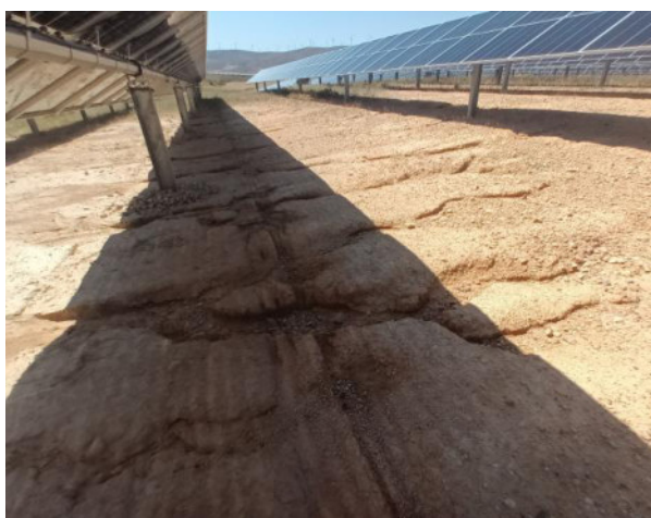
Erosiones bajo los módulos en el mes de agosto en la parcela 1 (izq) y en la parcela 4 (dch).
