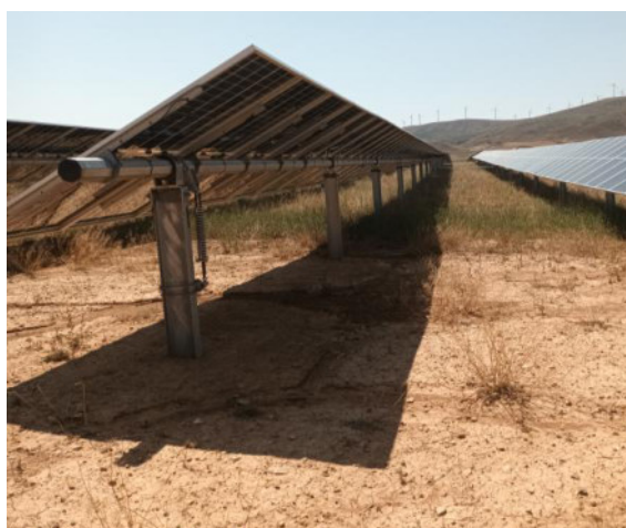
Erosiones bajo los módulos en el mes de agosto en la parcela 1 (izq) y en la parcela 4 (dch).
