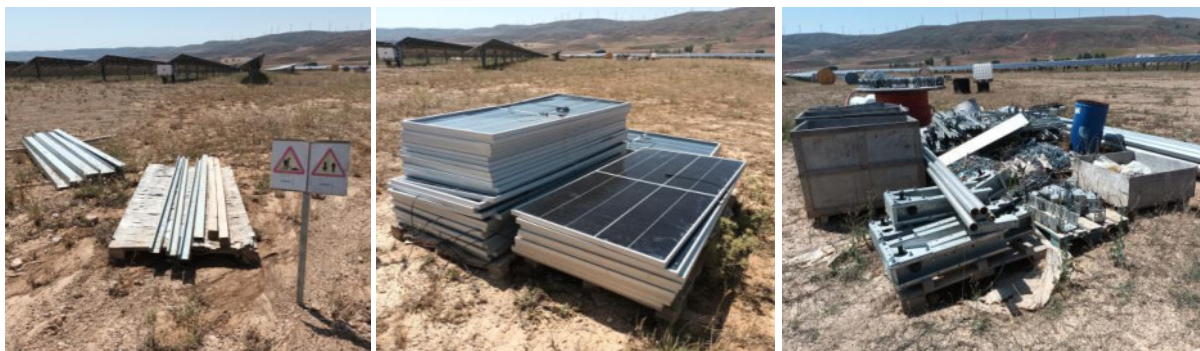
Zonas de acopio de material en la parcela 4 en el mes de agosto.
