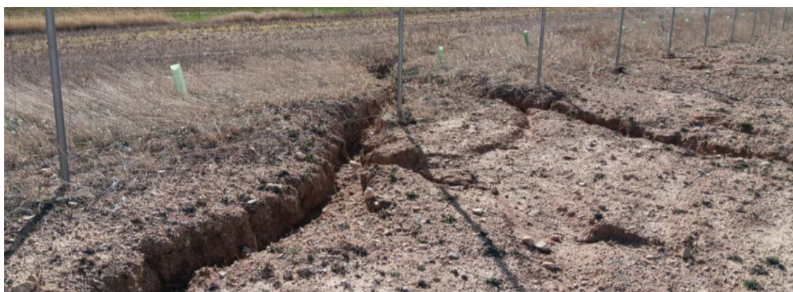
Erosiones de la parcela 7 en enero en zonas de vallado que comprometen su estructura.
