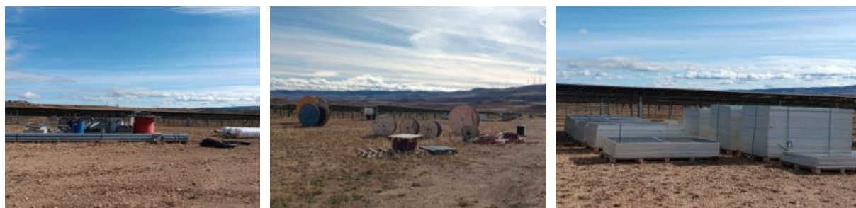
Zonas de acopio de material en la parcela 4 en el mes de enero.
