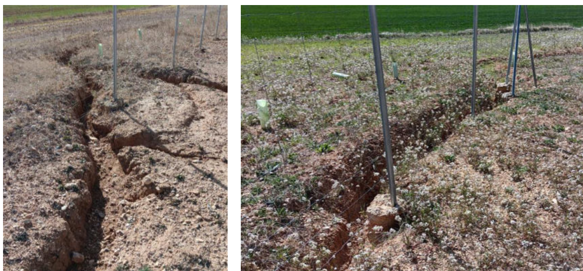
Puntos críticos de erosión que afectan al vallado de la parcela 7 en enero (izq) y abril (dch).
