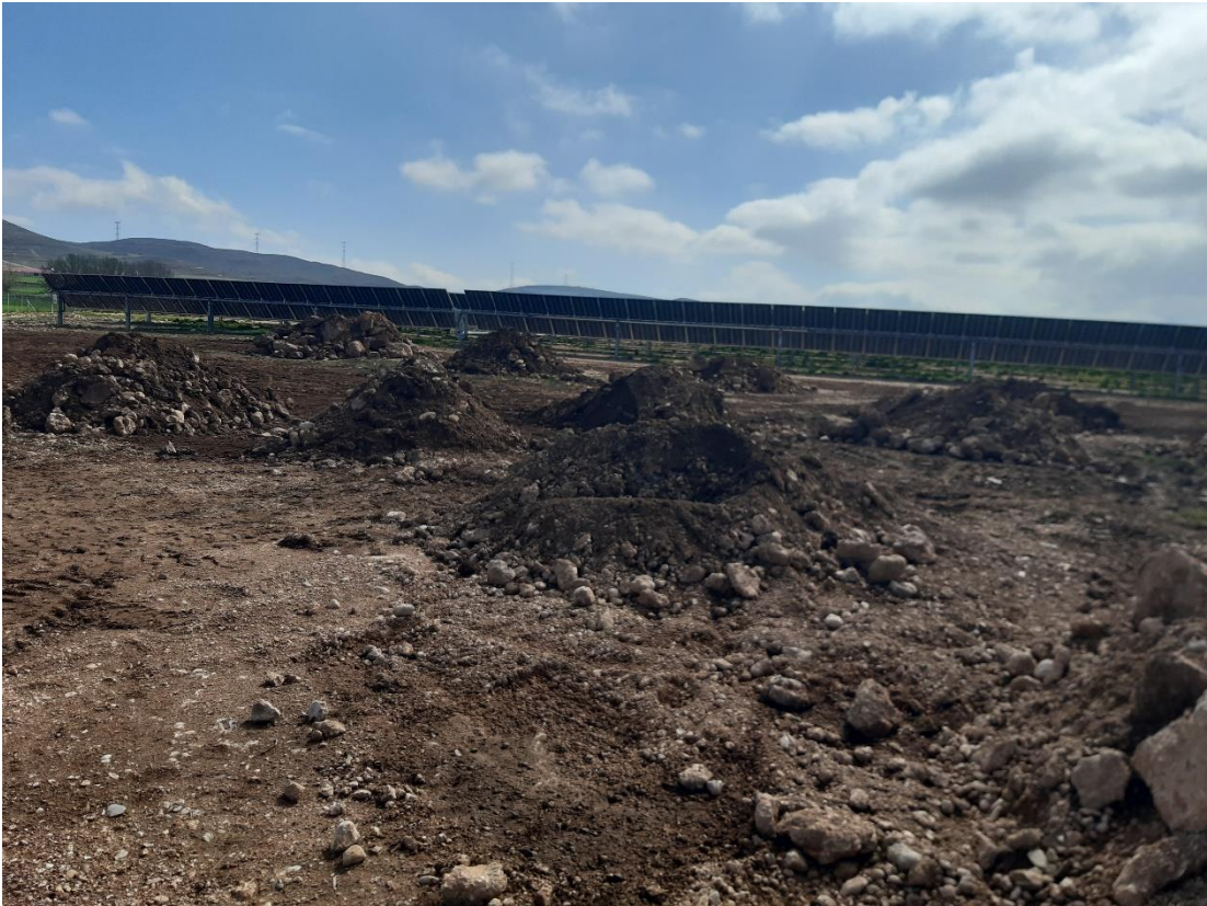
Fig. 1 Acopios de tierra vegetal en parcela 5.
