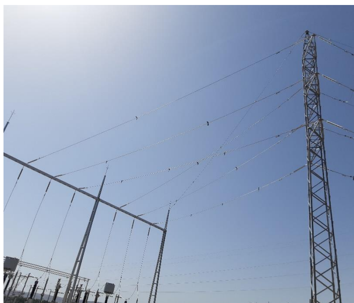
Fig. 2 Balizas salvapájaros en inicio de la LAAT
