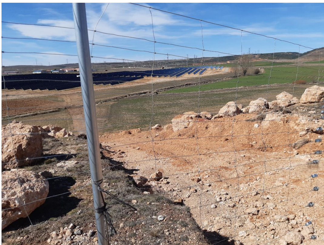
Fig. 1 Estado actual de zanja con excedentes de excavación
