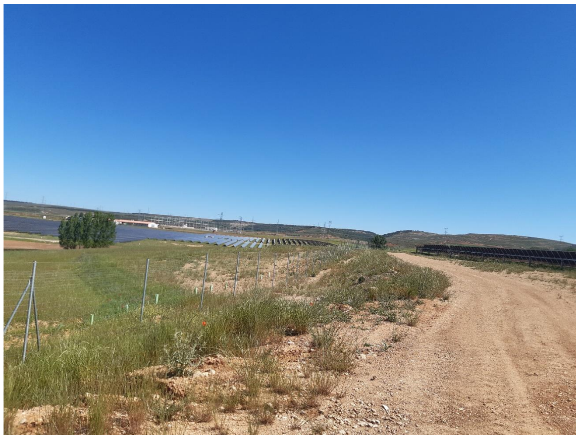
Fig. 1 Talud revegetado de manera natural en parcela 5
