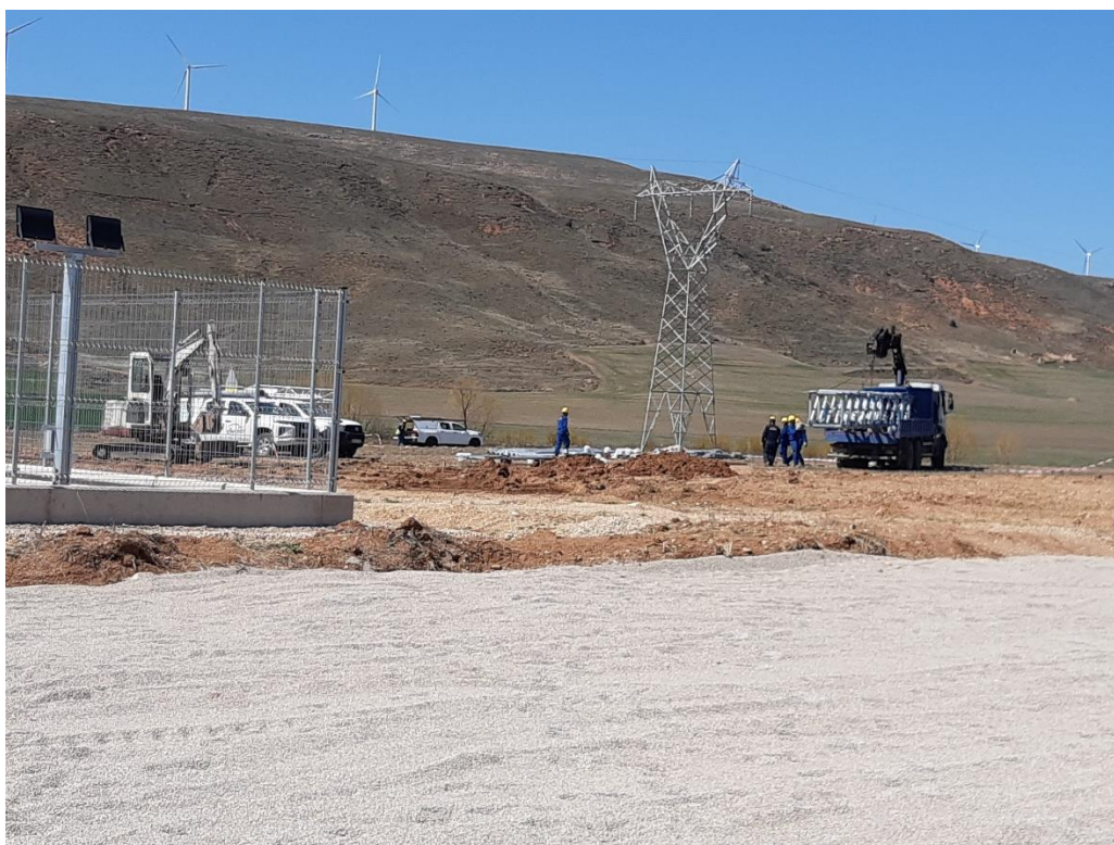
Fig. 1 Operarios trabajando en izado de apoyos
