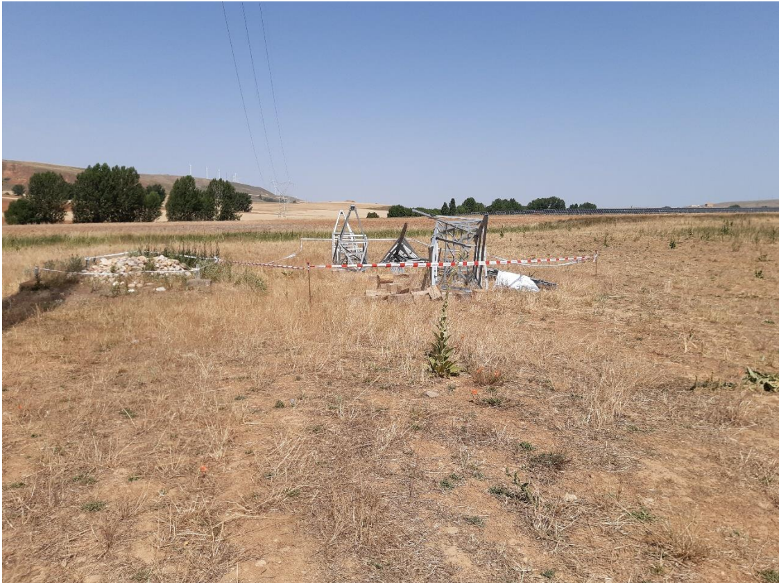
Fig. 1 Apoyo desmontado pendiente de retirada
