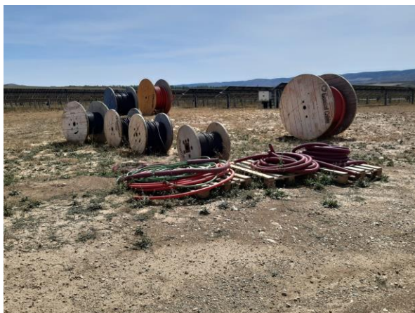
Zona de acopio de material.
