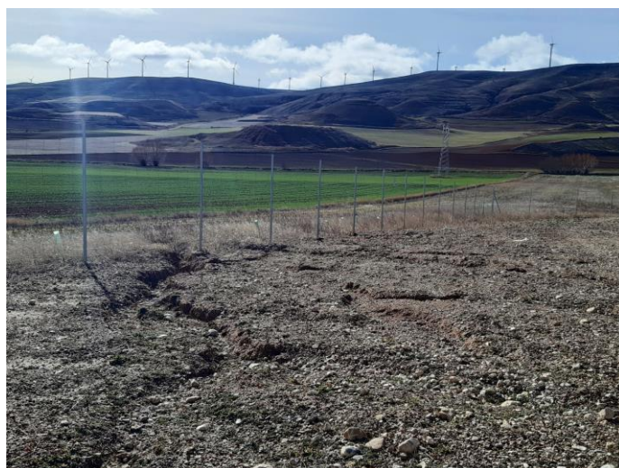
Erosiones varias en zonas próximas a vallado o propias de vallado que comprometen su estructura.
