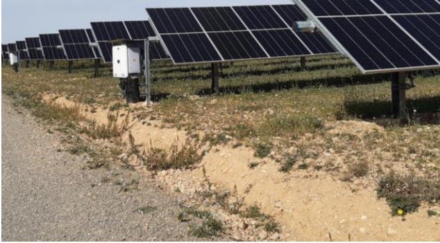
Drenajes colapsados de vegetación que ha crecido (izquierda) o bien de material terroso (derecha).
