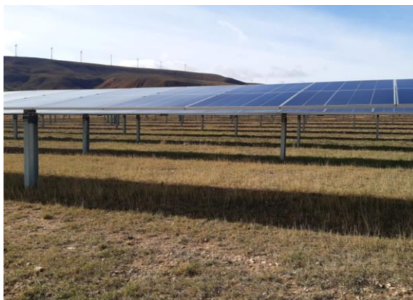
Una regeneración adecuada y uniforme en diciembre.
