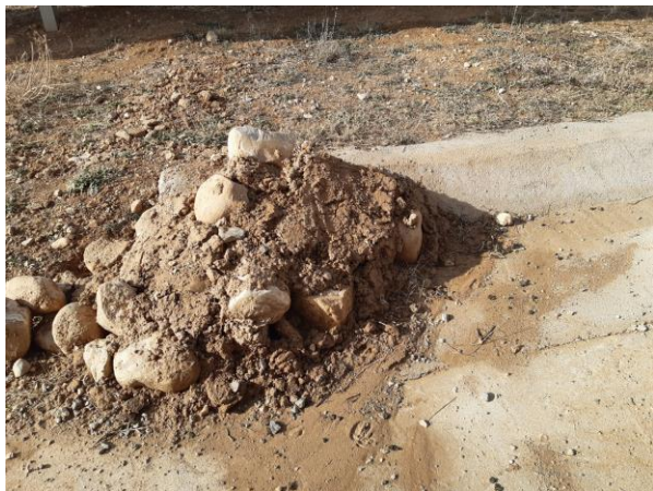
Drenajes colapsados de material (rocas y tierra) impidiendo el curso de agua.
