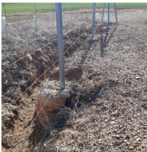
Erosiones varias en zonas próximas a vallado o propias de vallado que comprometen su estructura.
