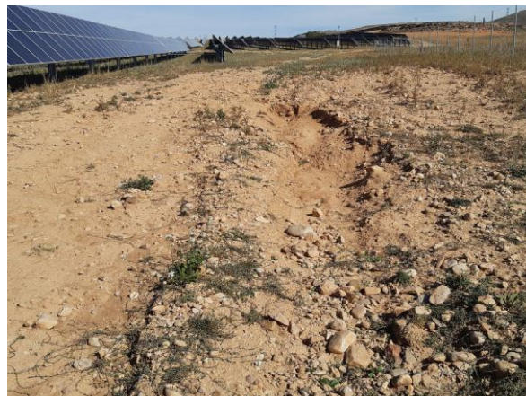
Erosiones en el mes de octubre.
