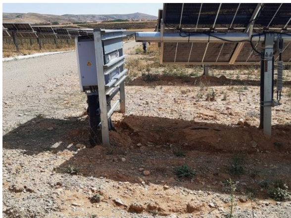
Erosiones bajo los inversores y seguidores.
