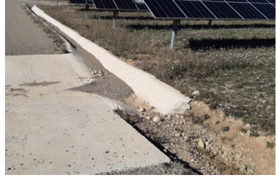
Drenajes colapsados de vegetación que ha crecido (izquierda) o bien de material terroso (derecha).
