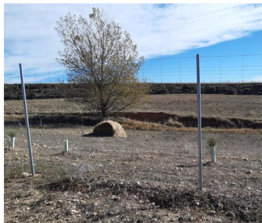
Estado de la pantalla en noviembre.
