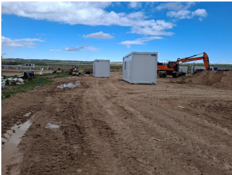
Figura 8.11. Casetas prefabricadas localizadas en los terrenos entre "San Pedro" y "Épila". Se identifican zonas encharcadas en estos terrenos.
