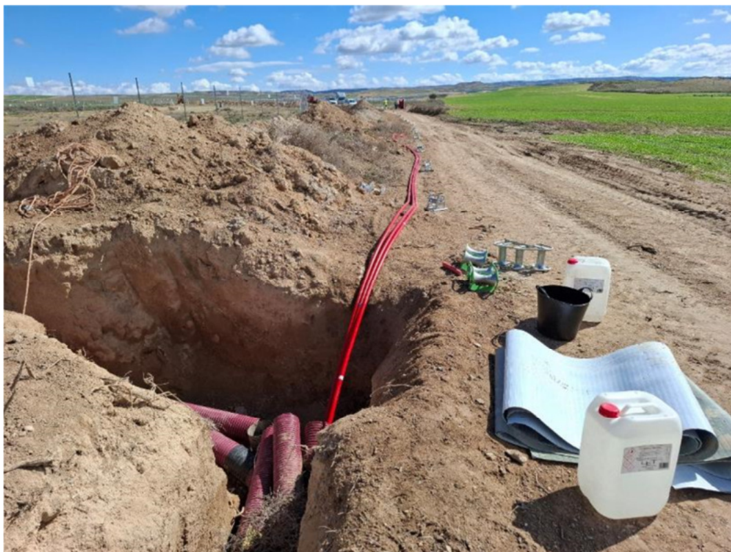
Figura 4.2. Colocación de cableado en zanja exterior
