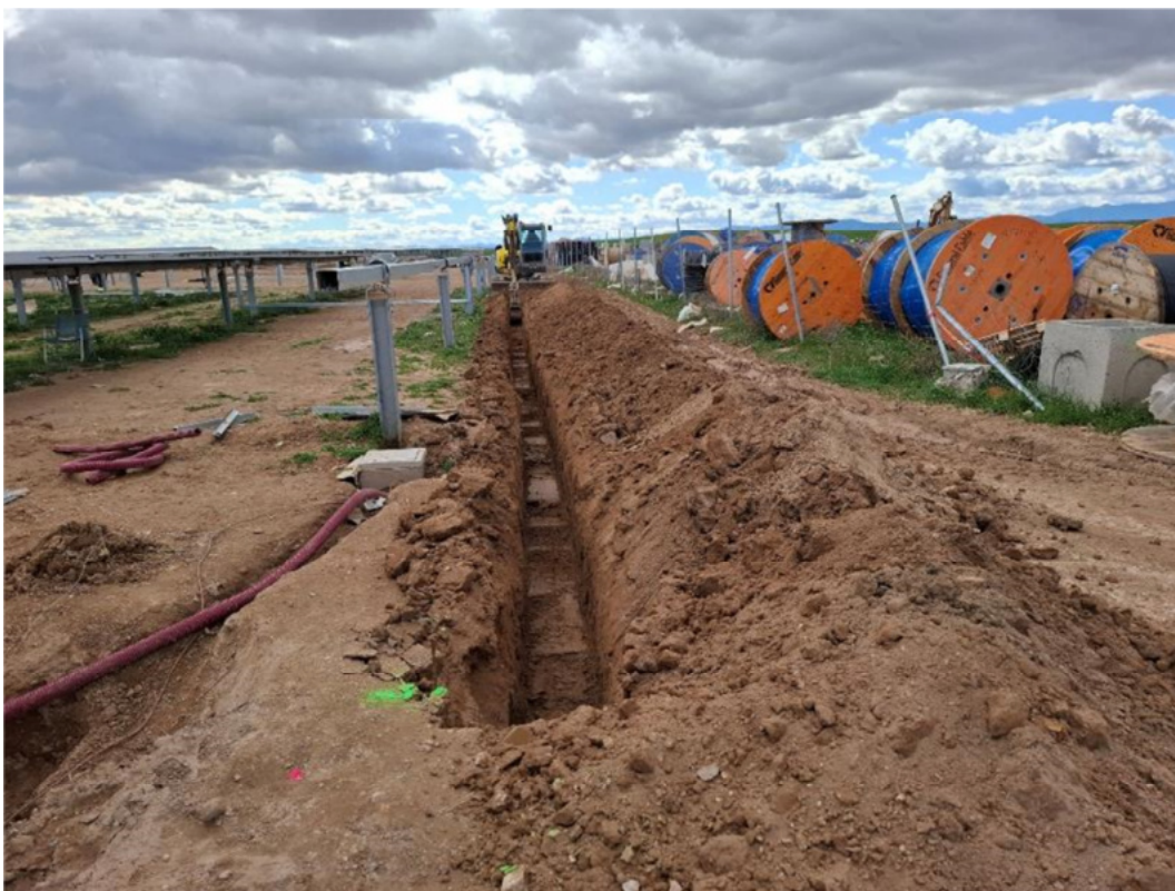
Figura 4.1. Apertura de una zanja interior en el límite oriental de la planta.
