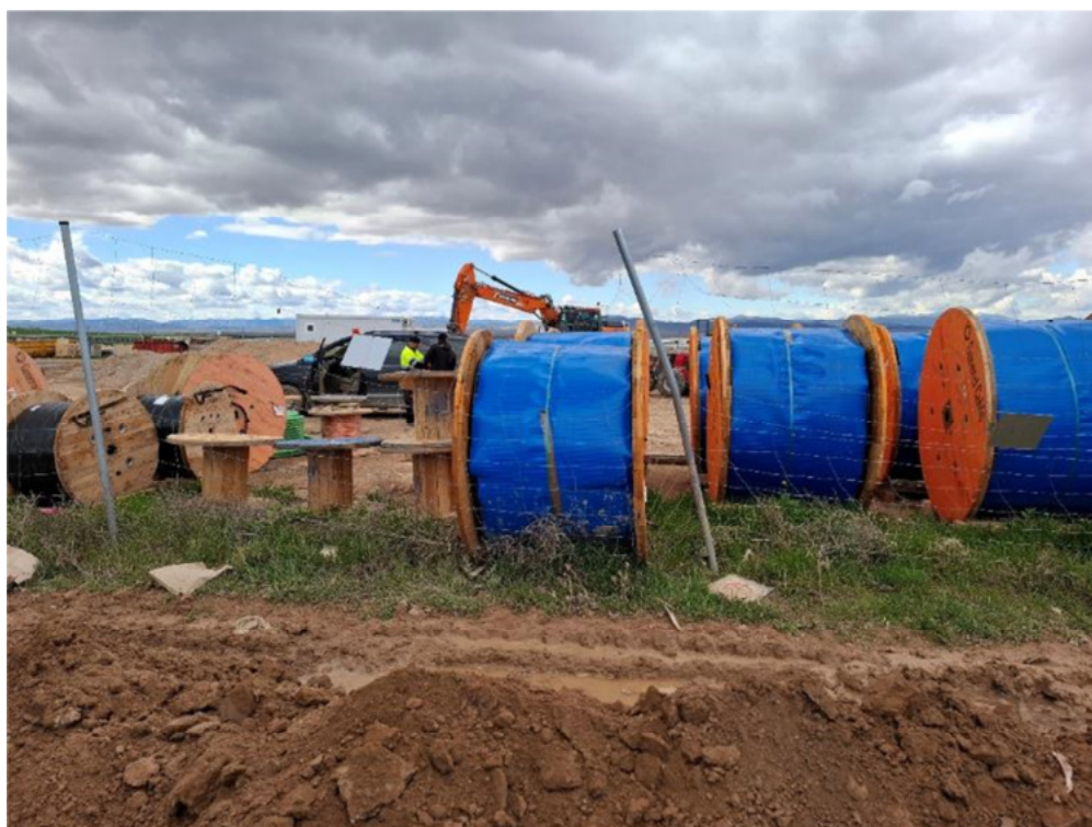
Figura 8.2. Vallado descolocado, aunque no roto, en el extremo occidental de la planta
