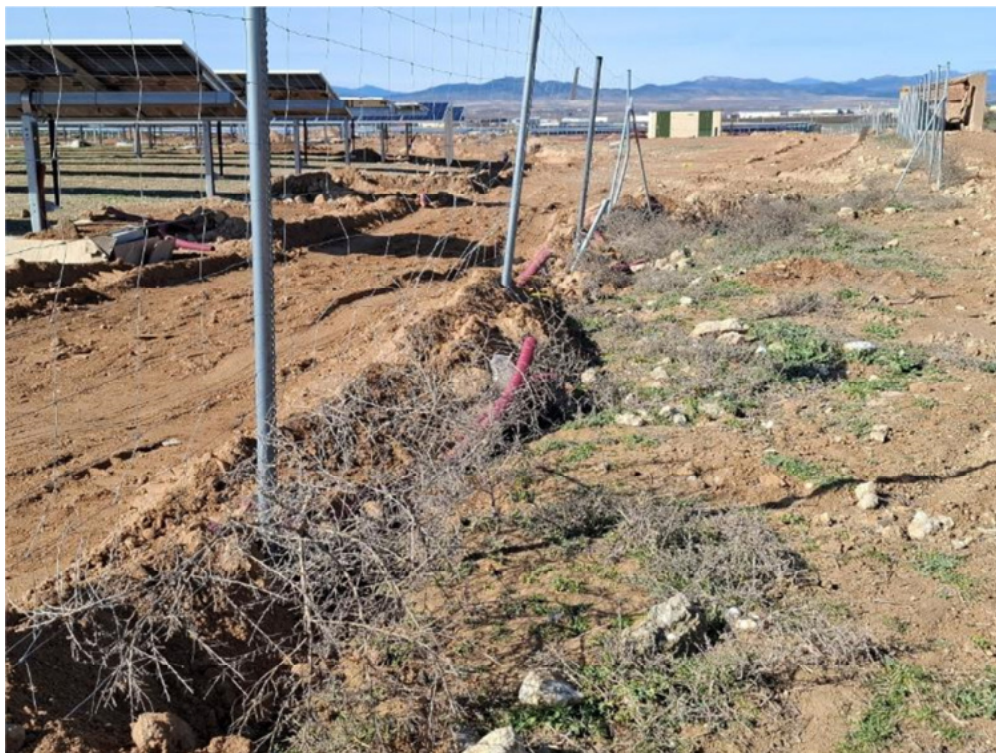
Figura 8.11. Tramo del vallado con el paso de fauna inferior obstruido, debido a los sobrantes de tierras procedentes de las zanjas
