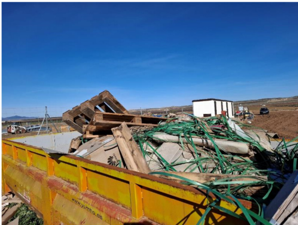
Figura 8.13. Residuos mezclados en el otro contenedor situado entre las plantas "Épila" y "San Pedro"
