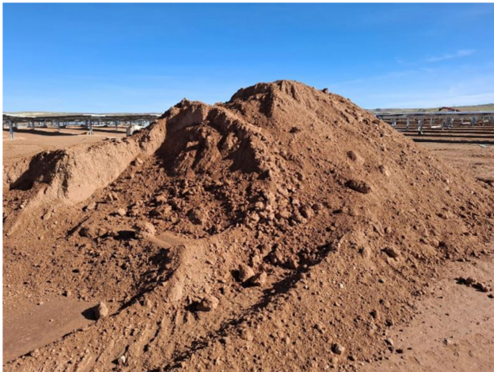
Figura 8.8. Acopio de tierra vegetal de unos 2 m de altura y sin balizar, localizado en la planta "Épila"
