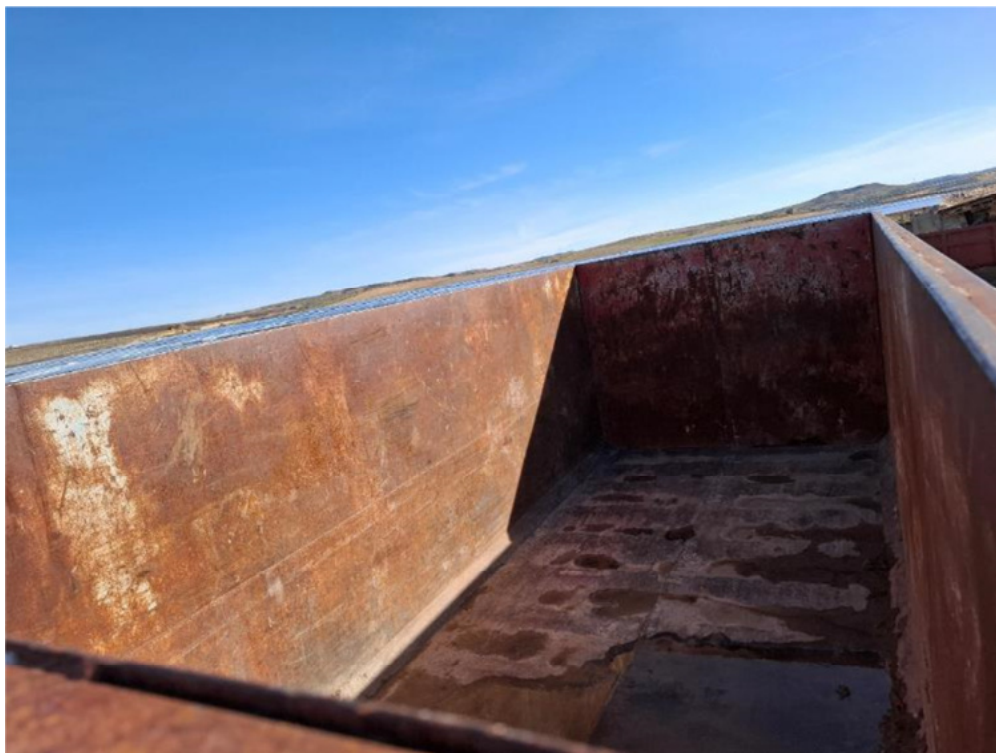
Figura 8.7. Contenedor vacío, instalado en la planta "Épila"
