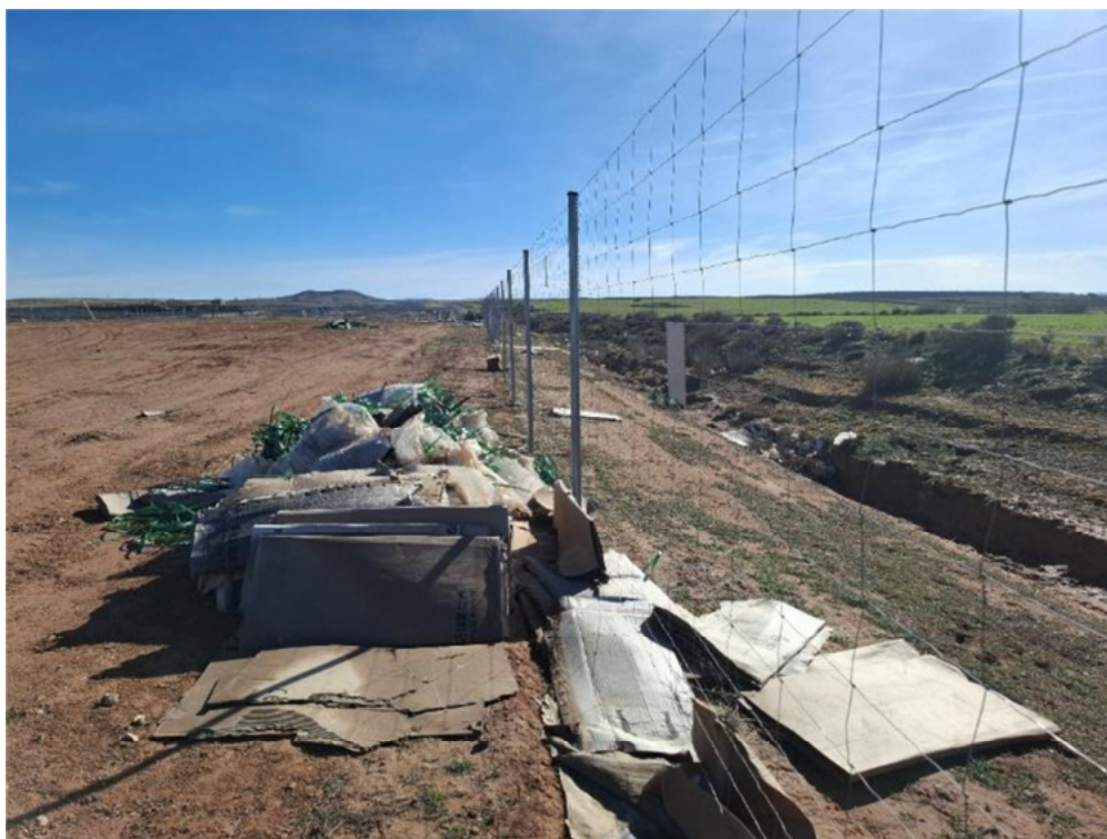
Figura 8.9. Acumulación de residuos y residuos dispersos en el límite sur de la planta, tanto en el interior como en el exterior de la misma
