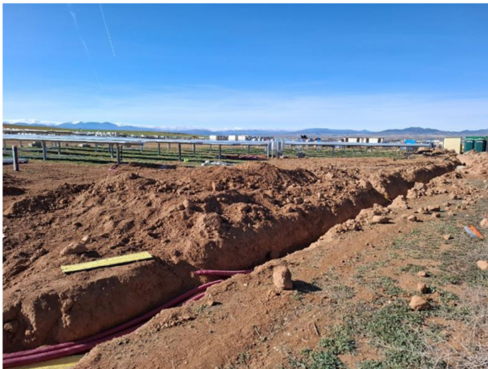
Figura 8.1. Aspecto de la planta a fecha 13-02-2025. Todavía quedan zanjas por cerrar
