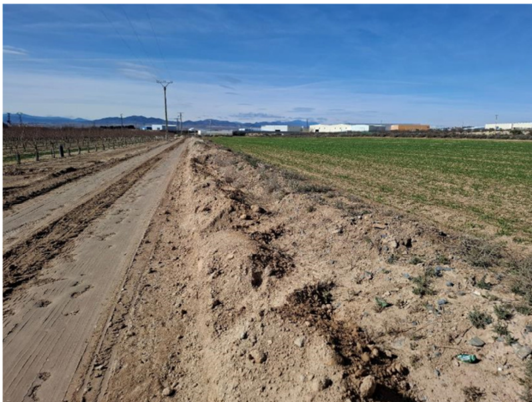
Figura 4.2. Zanja exterior cerrada
