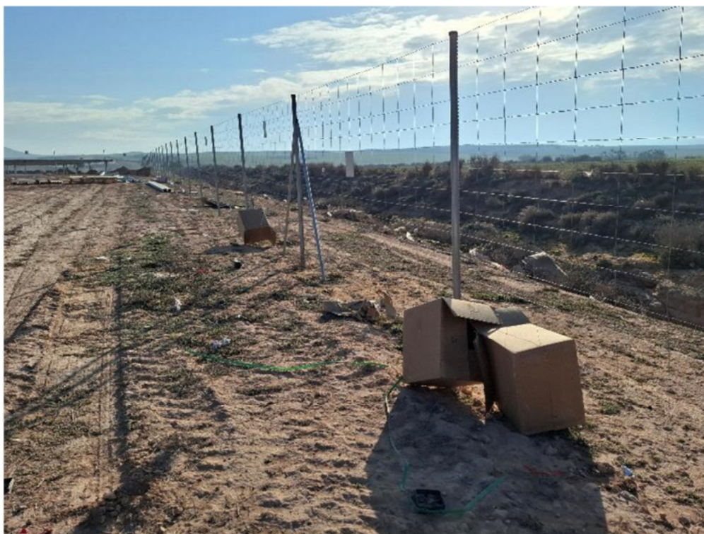
Figura 8.3. Residuos dispersos en el límite sur de la planta, tanto en el interior como en el exterior de la misma
