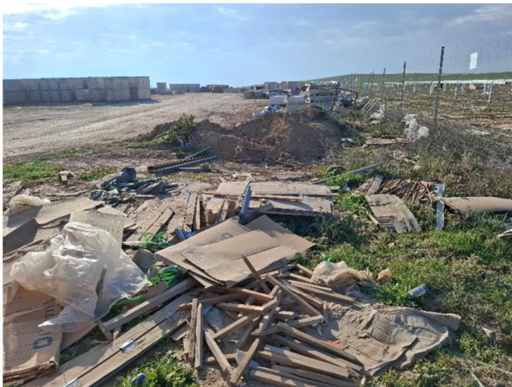
Figura 8.13. Residuos en el suelo y junto al acopio de tierra vegetal, junto a los contenedores situados entre las plantas "Épila" y "San Pedro"
