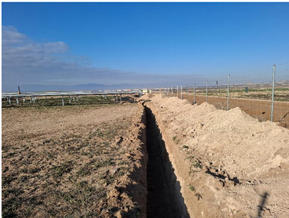
Figura 8.5. Zanja interior que discurre por el límite norte de la planta
