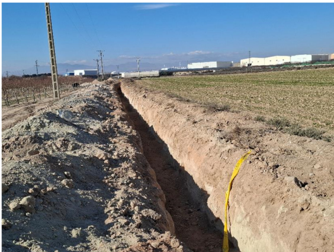
Figura 4.2. Zanja exterior abierta
