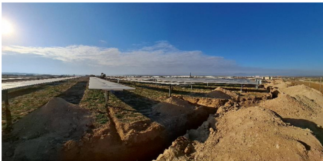
Figura 8.1. Aspecto de la planta a fecha 17-01-2025. Se continua con la colocación de placas y apertura de zanjas
