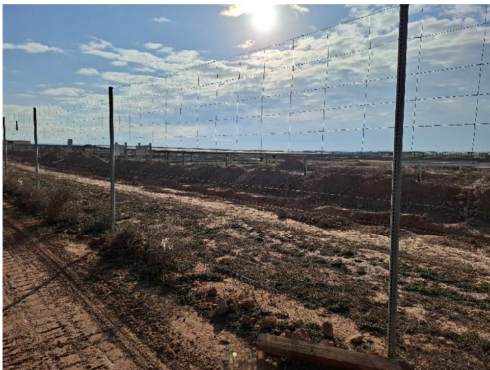
Figura 8.9. Placa ausente en un punto del vallado
