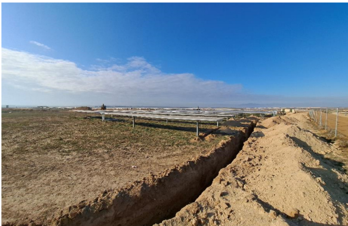
Figura 4.1. Aspecto de la planta el 17-01-2025
