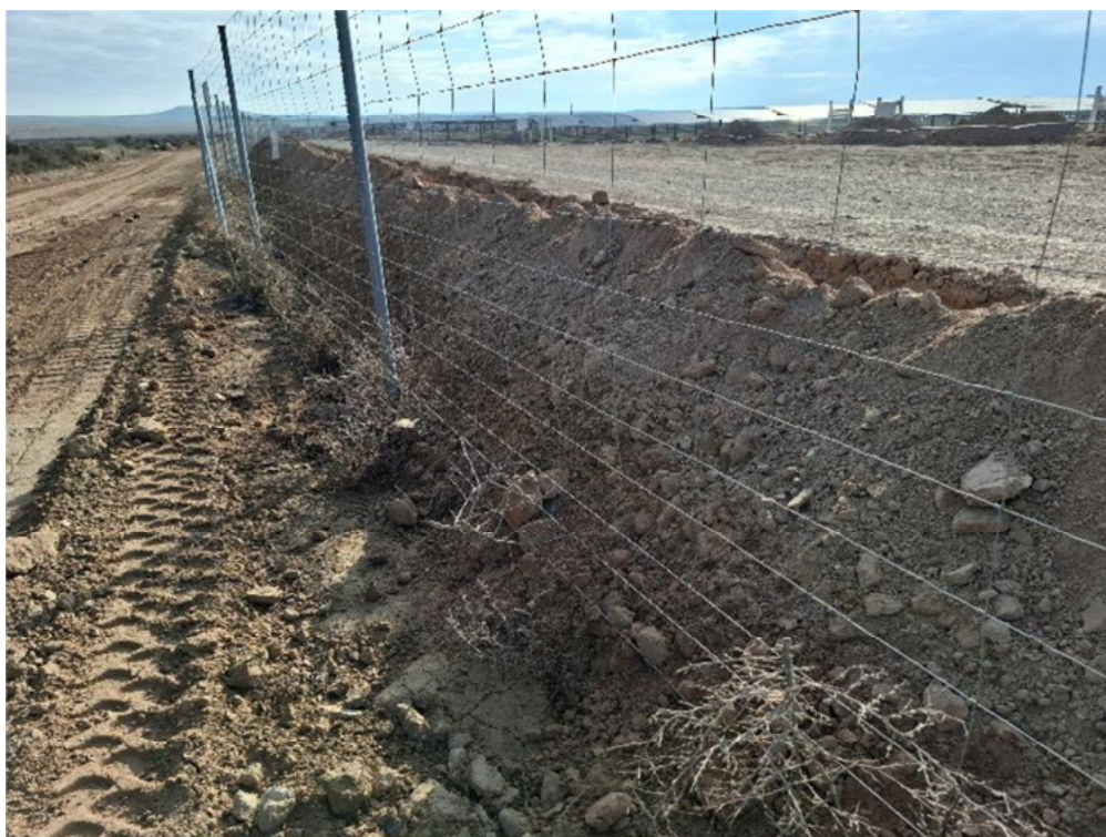
Figura 8.10. Tramo del vallado con el paso de fauna inferior obstruido, debido a los acopios de tierras de las zanjas exteriores
