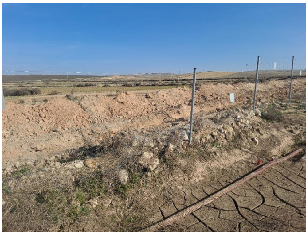
Figura 8.4. Obstrucción del paso de fauna inferior en un tramo del vallado, debido a los movimientos de tierra ejecutados en el exterior del recinto
