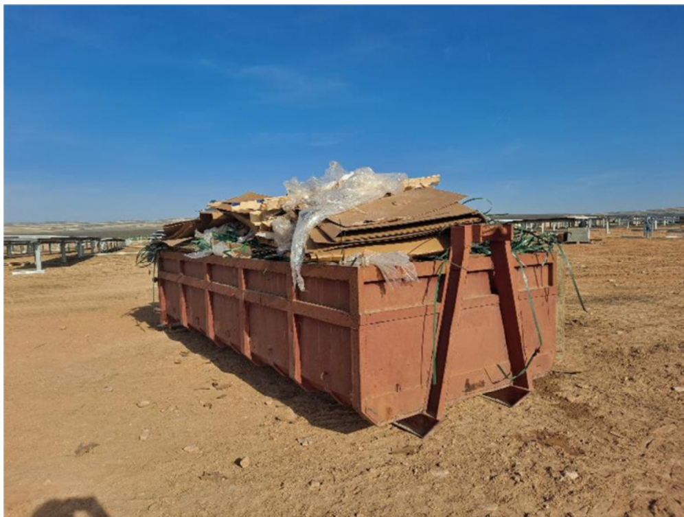
Figura 8.3. Residuos mezclados en el contenedor instalado en el interior de "Épila"
