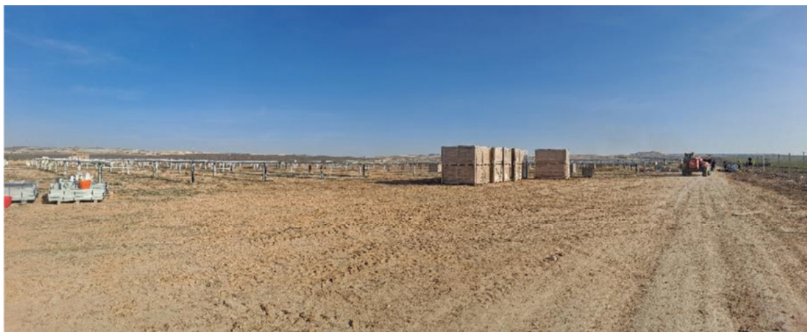
Figura 4.1. Aspecto de la planta el 18-12-2024
