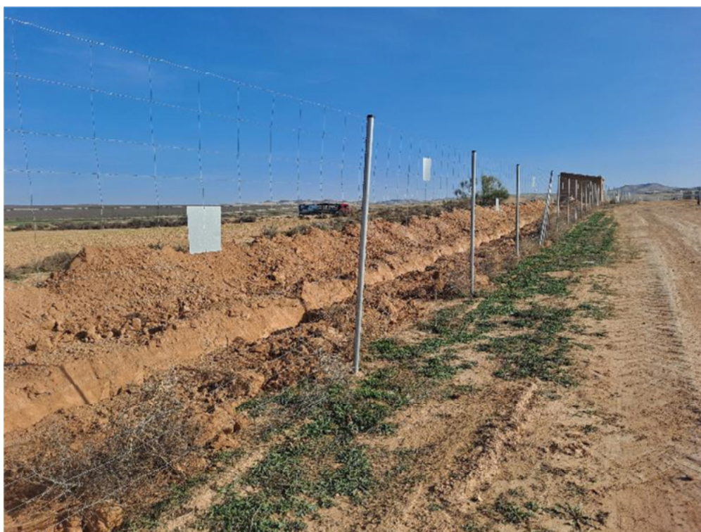
Figura 8.6. Zanja exterior donde no se ha separado la tierra vegetal del resto de tierras
