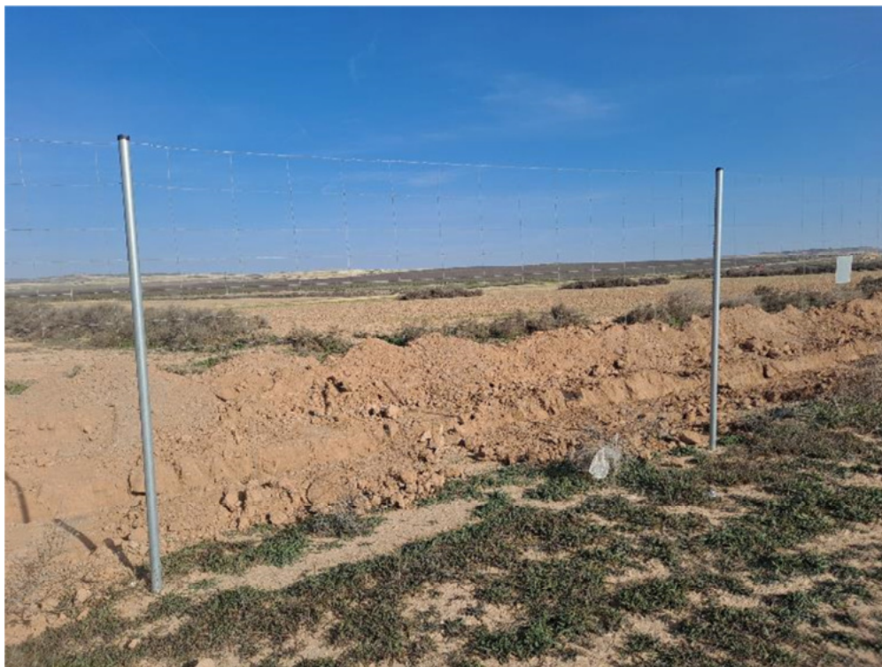
Figura 8.5. Vano sin placa de visibilidad en el límite norte del vallado
