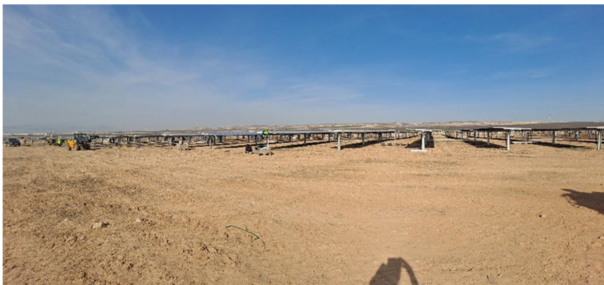
Figura 8.1. Aspecto de la planta a fecha 18-12-2024. Se están colocando placas y abriendo zanjas
