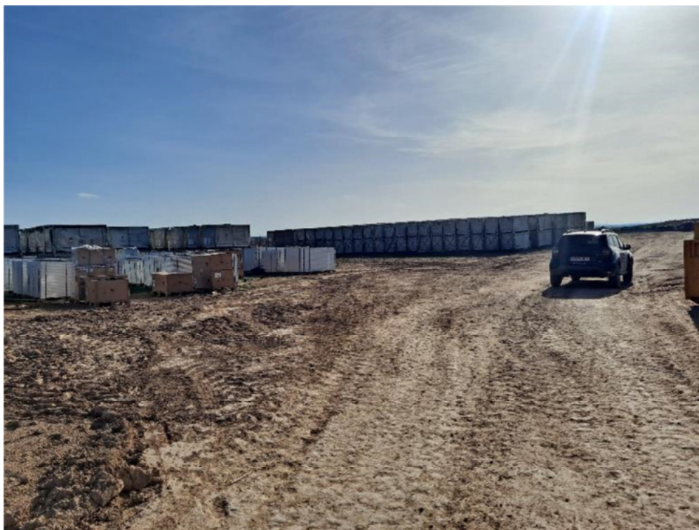
Figura 8.9. Acopios de materiales para las obras situados entre las plantas "San Pedro" y Épila"
