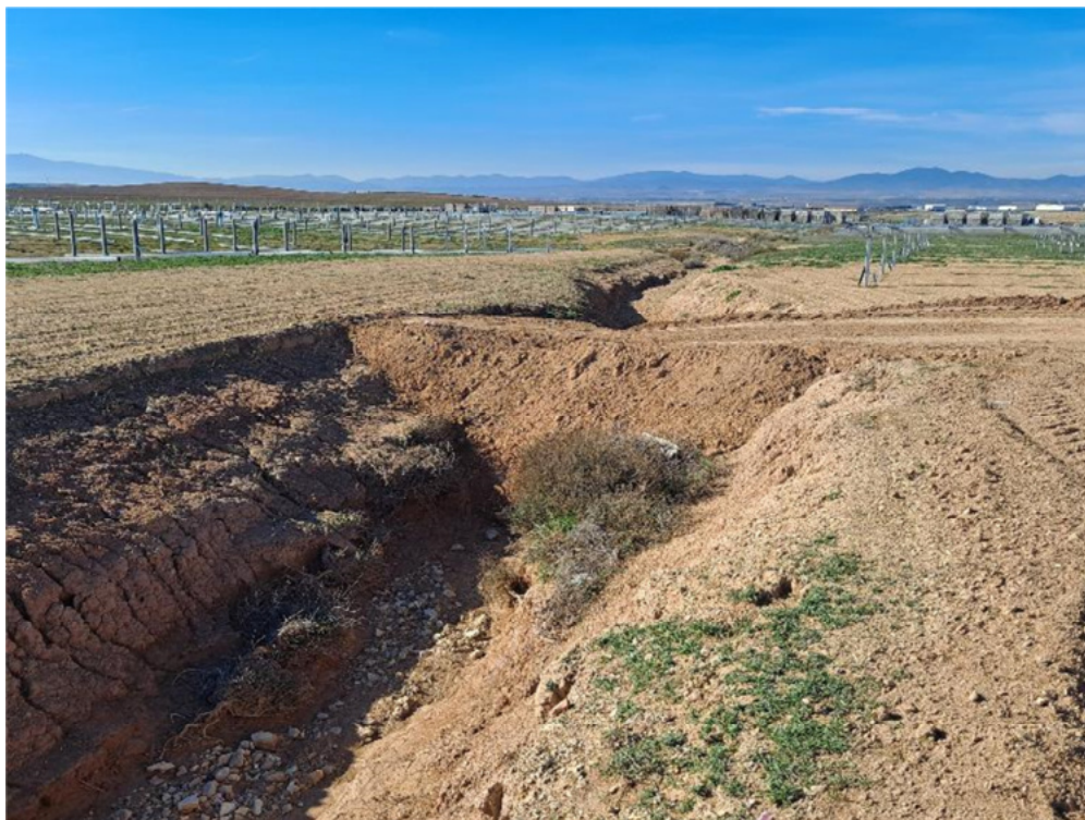
Figura 8.5. Nuevo paso realizado sobre el barranco que atraviesa la parcela
