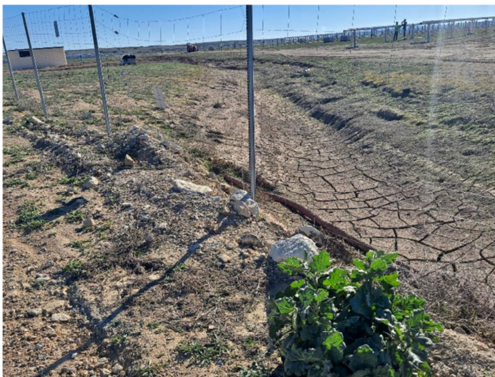
Figura 8.6. Obstrucción del paso inferior de fauna del vallado
