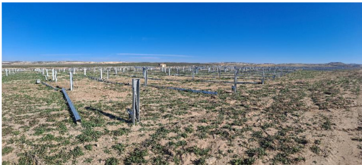
Figura 4.1. Aspecto de la planta. Instalación de seguidores.
