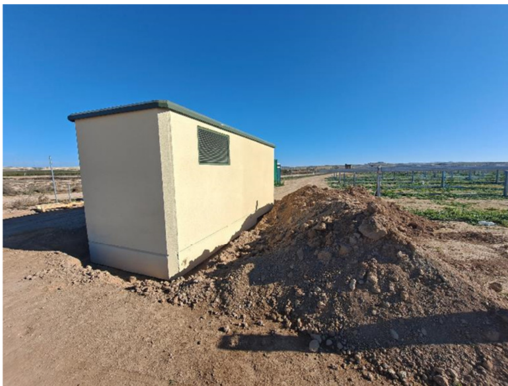
Figura 8.2. Acopio de tierra vegetal junto al centro de transformación situado a la entrada de la planta
