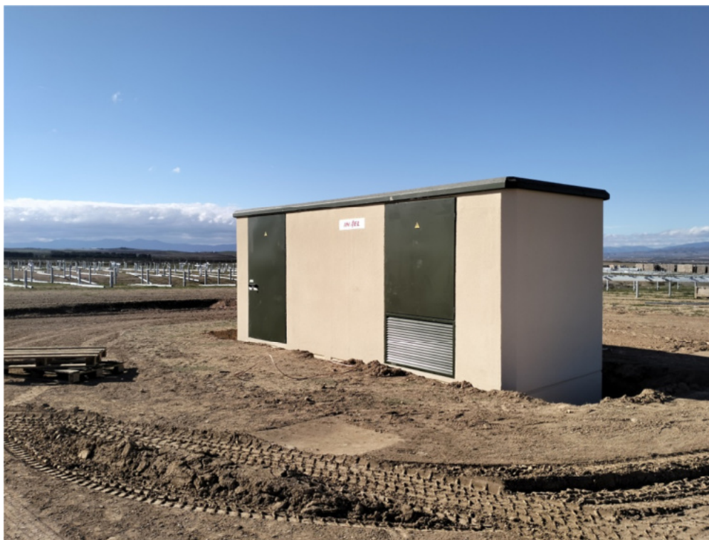
Figura 4.3. Aspecto de la planta. Instalación de CT.
