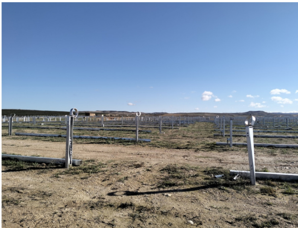
Figura 4.1. Aspecto de la planta. Instalación de seguidores.
