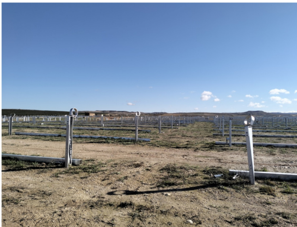
Figura 8.2. Aspecto de la planta a fecha 30-10-24, por mitad occidental
