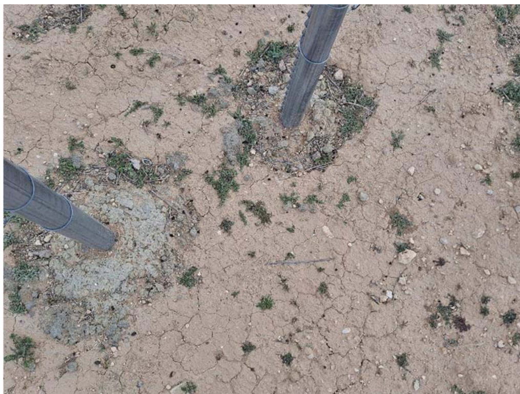
Figura 8.4. Alambres en el suelo junto a los pasos de fauna
