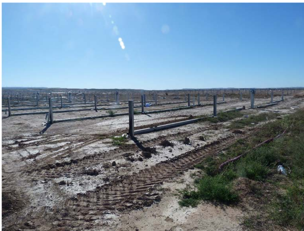
Figura 4.1. Aspecto de la planta
